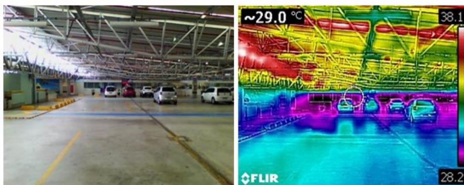
Figura 4-24 - Foto Termográfica - Porção central do Estacionamento G6 com administração do shopping a frente
