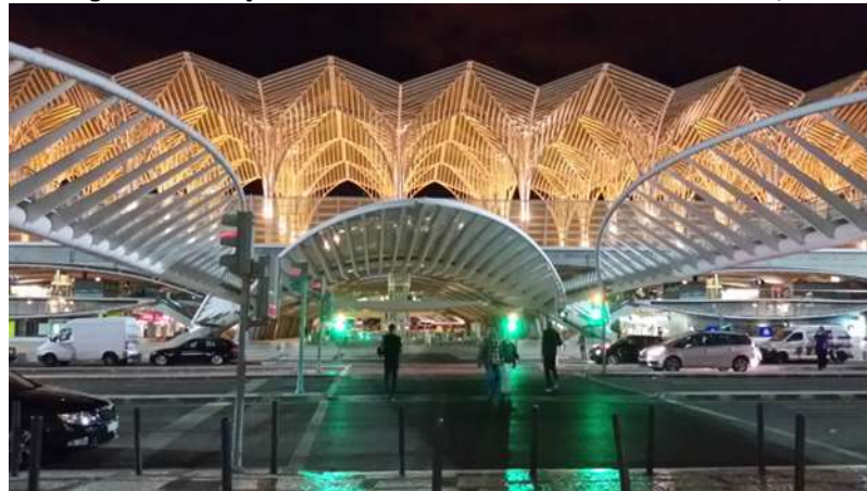
Figura 3-6 - Estação Intermodal do Oriente. Fachada Leste. Lisboa/PT
