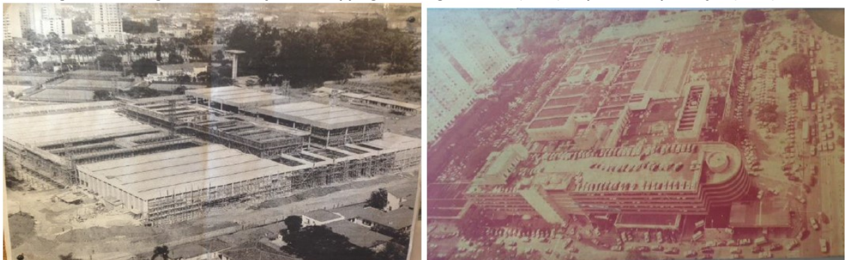
Figura 2-1 - Imagem da Construção do Shopping Center Iguatemi SP (1965) e após sua implantação (1981)
