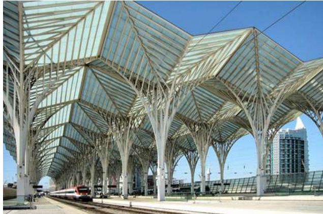
Figura 3-12 - Cobertura do terminal ferroviário com pilares em formato de árvore
