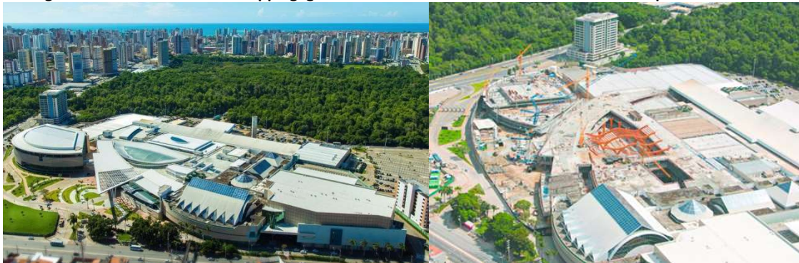
Figura 3-22 - Vista aérea do Shopping Iguatemi Fortaleza finalizado e durante a sexta expansão em 2015
