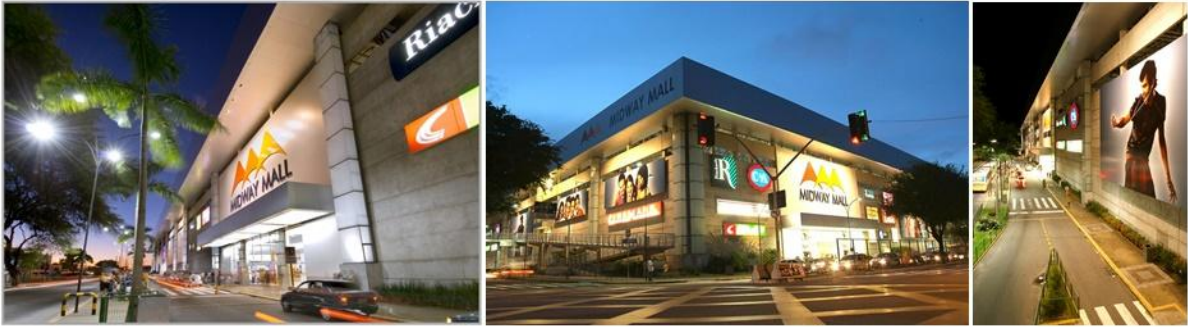
Figura 4-12 - Imagens da fachada em concreto do Shopping Midway Mall
