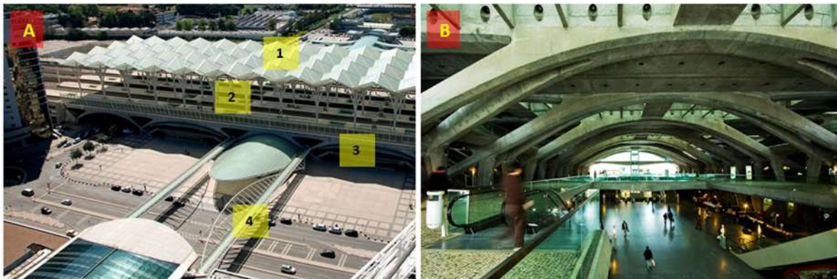
Figura 3-14 - A – Elementos de Conforto ambiental na Estação do Oriente; B – Interior da Estação com destaque para a iluminação natural
