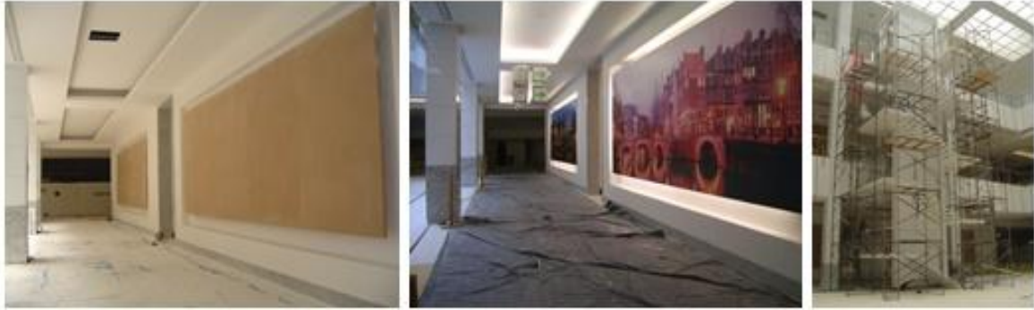
Figura 4-6 - Imagens da construção do Shopping Midway Mall
