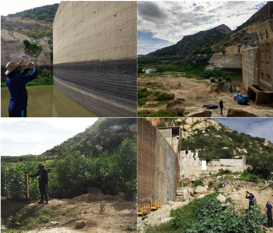
Figura 31: Equipe na área externa da barragem.
