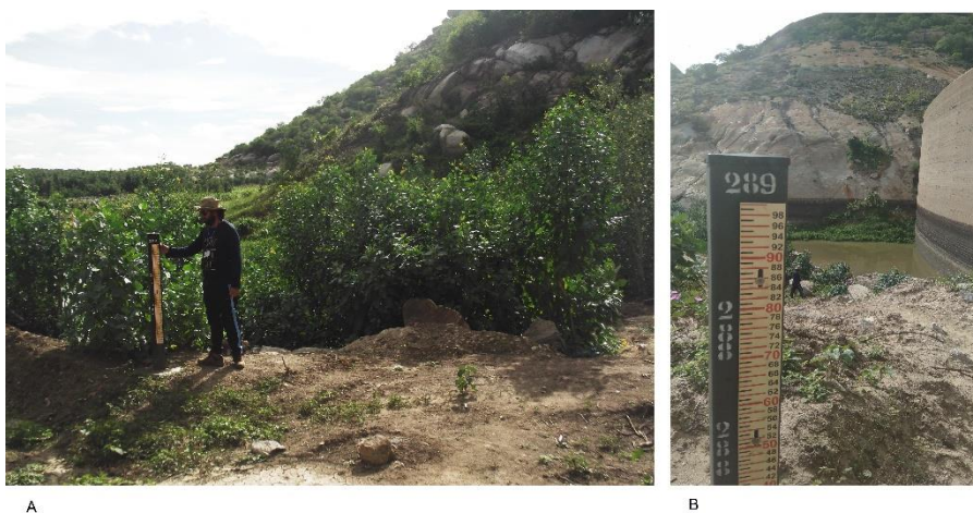
Figura 60: Dispositivos de monitoramento de volume de água na barragem.
