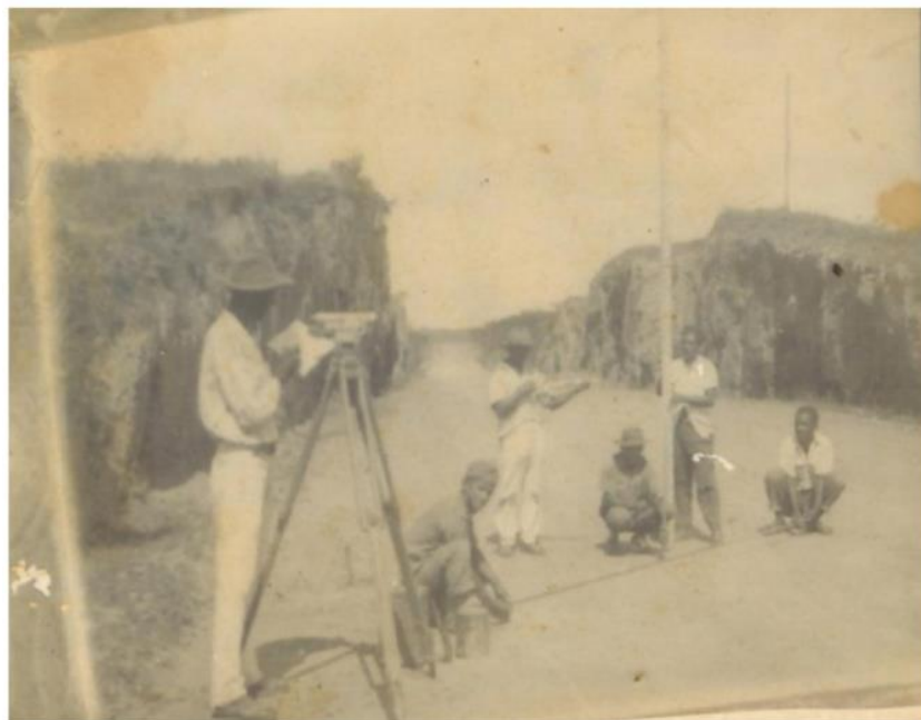
Figura 24: Estudos topográficos no canteiro de obras.
