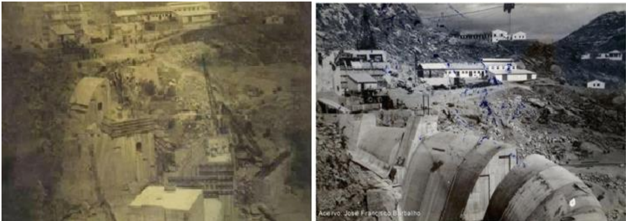
Figura 27: Visão panorâmica do canteiro de obra.
