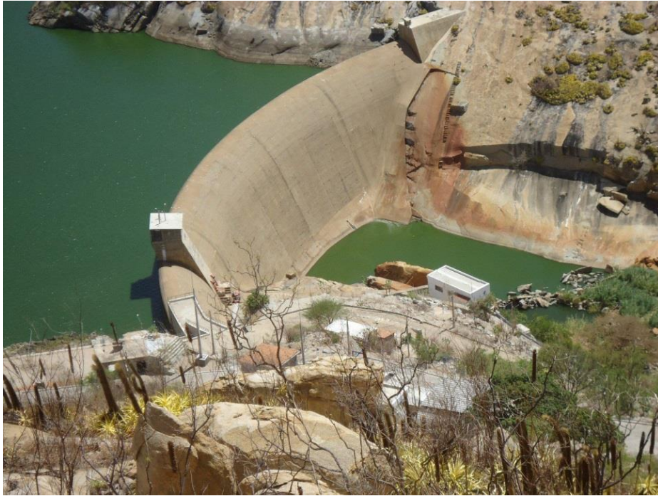
Figura 43: Barragem do tipo arco-gravidade. Barragem Gargalheiras, Acari/RN.
