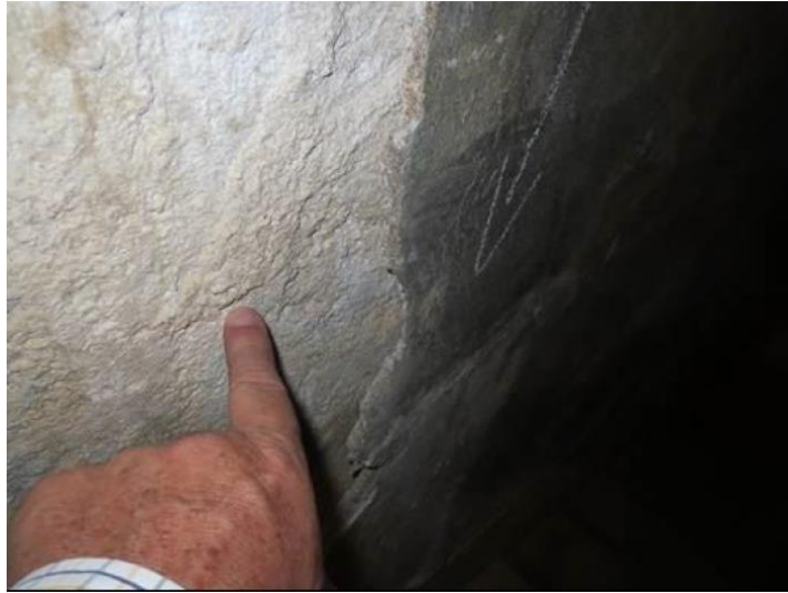
Figura 47: Processo de desencapamento de revestimento de parede da galeria.
