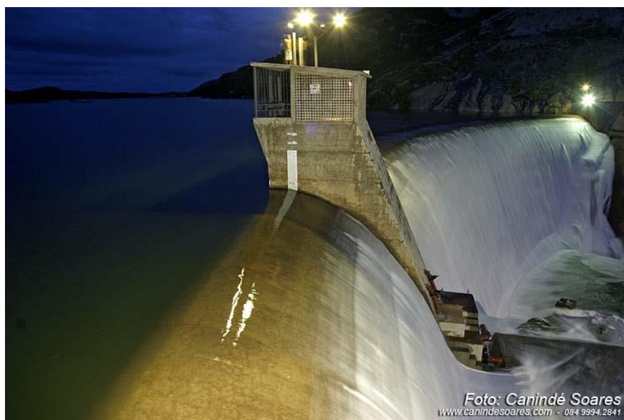
Figura 38: Barragem do tipo rígida (concreto) – Barragem Gargalheira, Acari/RN.
