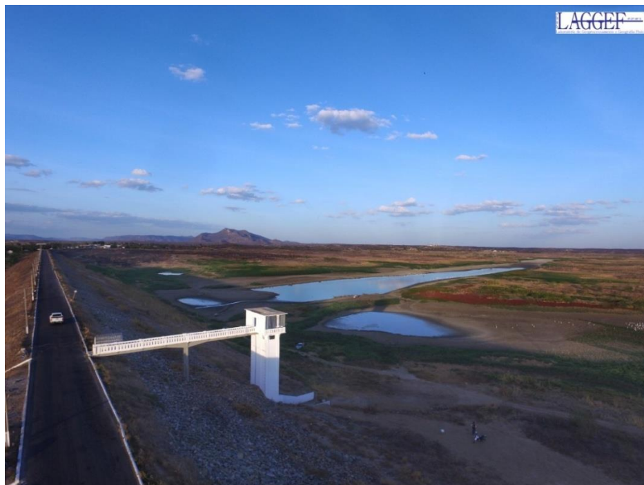
Figura 39: Barragem do tipo não rígida – Barragem Itans, em Caicó/RN
