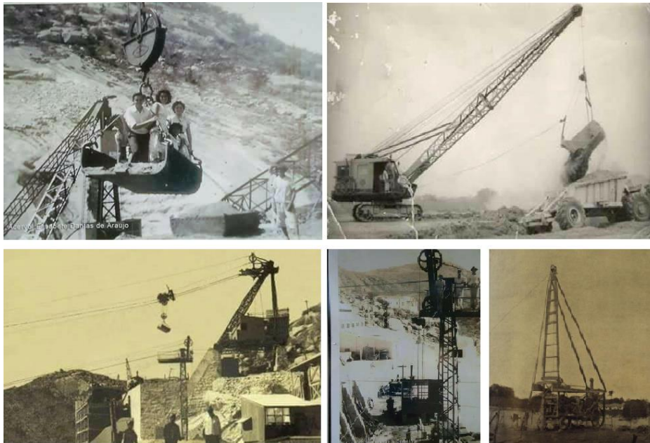
Figura 26: Guindastes e perfuratrizes usados durante as obras.
