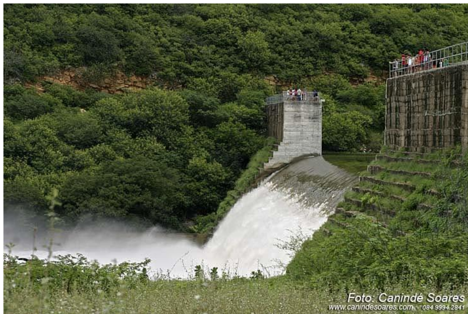
Figura 41: Barragem do tipo gravidade com compactação de concreto a rolo – Barragem Passagem das Traíras, em Jardim do Seridó/RN.
