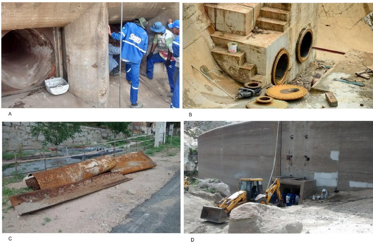
Figura 59: Reparos hidromecânicos no maciço.
