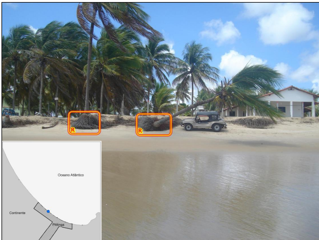
Figura 5.10 – Coqueiros com raízes (R) expostas evidenciando o processo de erosão existente. Foto: Eduardo Q. de Lima.
