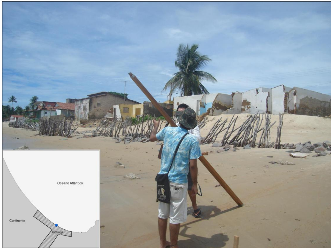
Figura 5.11 – Zona mais afetada pela erosão, utilização de cercas e pedras para conter a atuação do mar. Foto: Eduardo Q. de Lima.
