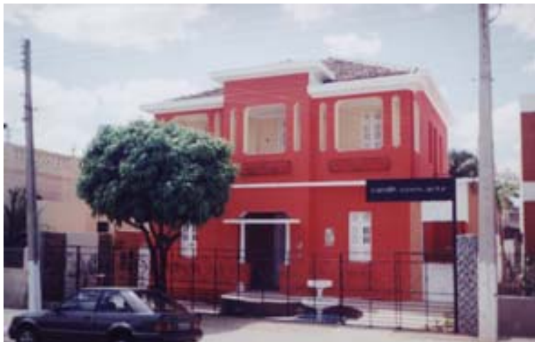
FOTO 3.1: Residência da Avenida Augusto Severo, Centro. Anos 40 Fonte: Karisa Lorena. 2005
