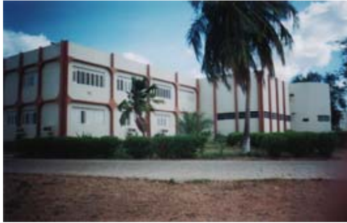
FOTO 3.10: ESAM - Edifício Administrativo, Costa e Silva (antes Alto São Manoel). 1967-69
