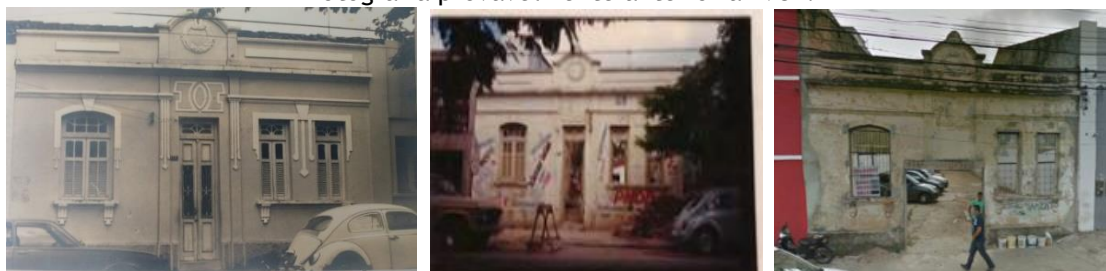
Figura 41 - Imóvel de Número 335 - Avenida Visconde de Pelotas. Da esquerda para a direita: Fotografia provavelmente anterior a 1987.
