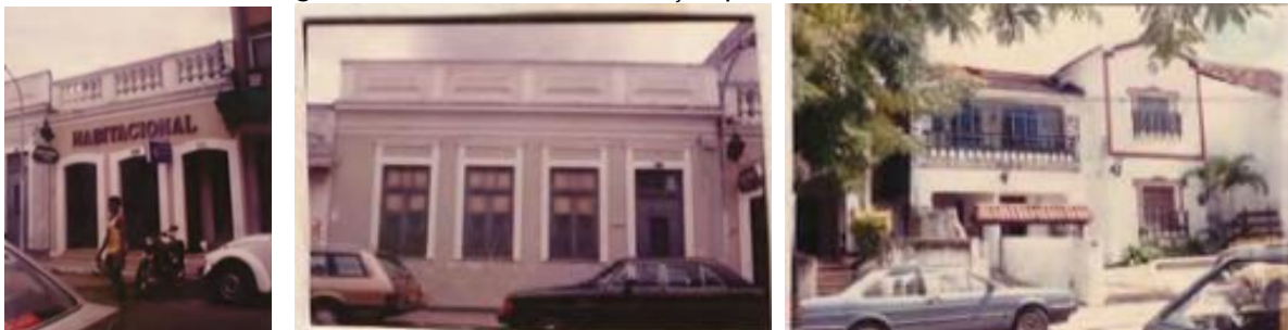
Figura 34 - Imóveis de “demolição possível” na Quadra 12.
