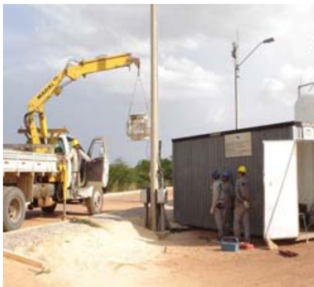
Figura 4.13: Montagem do sistema elétrico da UT-MDIF.
