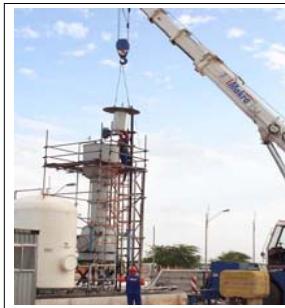
Figura 4.15: Montagem do reator da câmara de mistura da UT-MDIF.
