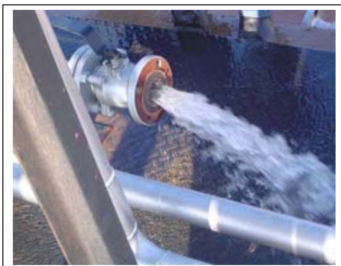
Figura 4.17. Etapa final de limpeza das linhas e equipamentos.
