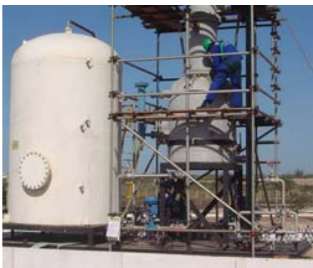
Figura 4.14: Montagem da coluna da UT-MDIF.
