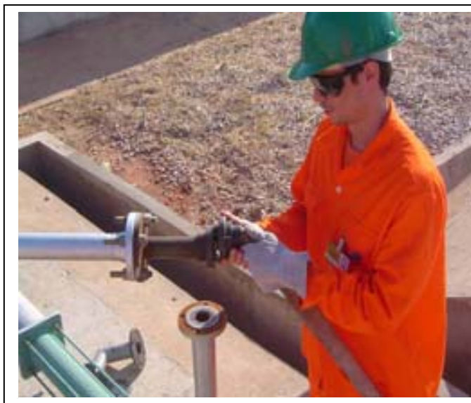
Figura 4.16: Preparação para a lavagem das linhas e equipamentos.
