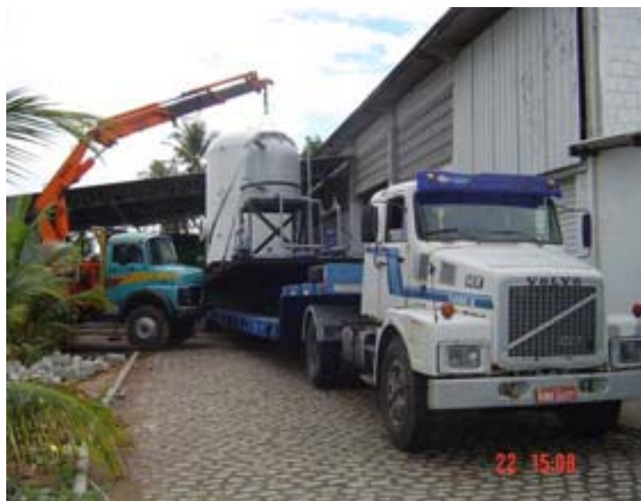
Figura 4.11: Operação de içamento do skid.
