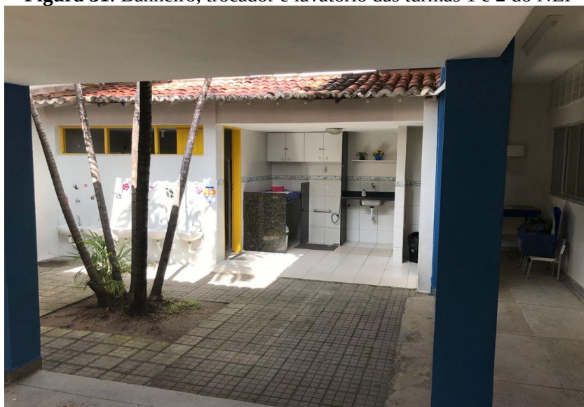
Figura 31: Banheiro, trocador e lavatório das turmas 1 e 2 do NEI
