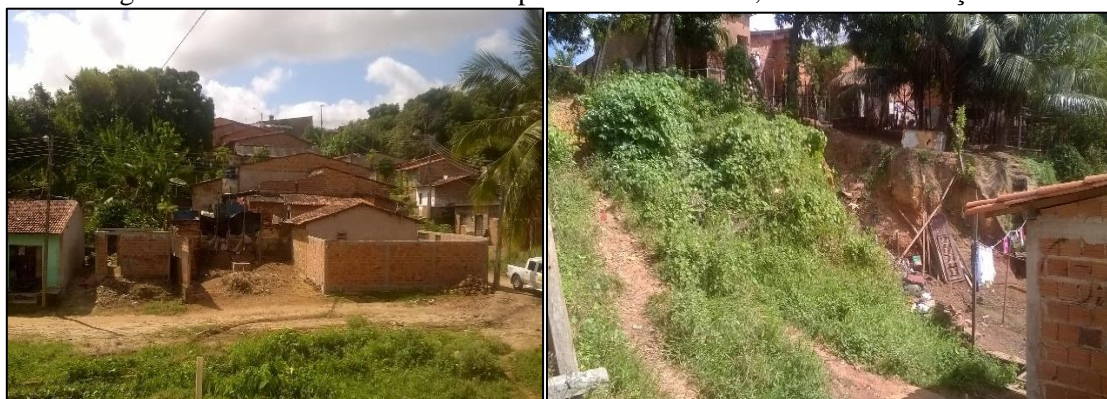
Figuras 15 - Inclinação da rua Nossa Senhora Aparecida no bairro Pão de Açúcar. Figura 16 - Residências localizadas próximas à encostas, bairro Pão de Açúcar.
