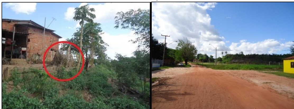
Figura 39 - Comunidade Rio Grande (zona rural) apresentando instalação de residência em ambiente instável (à esquerda) e Figura 40 - Ausência de asfalto Comunidade Rio Grande (à direita).
