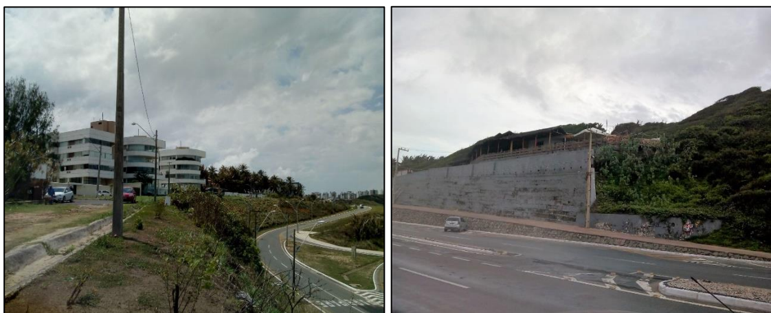
Figura 60 e 61– Construção de hotéis e casa de festa na Avenida Litorânea.
