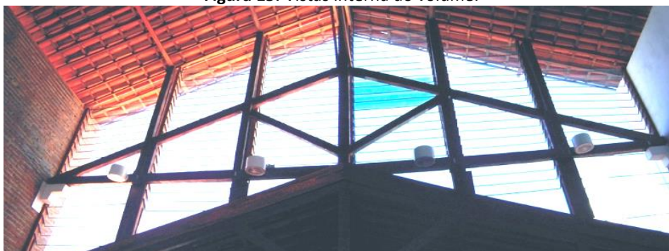
Figura 15: Vistas interna do volume.
