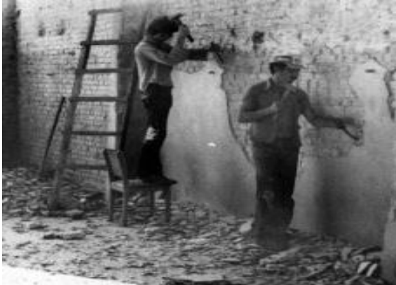
Figura 3: Retirada do reboco das paredes originais do galpão de atividades gerais, abril 1980.
