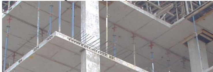
Figura 151: Laje com protensão.
