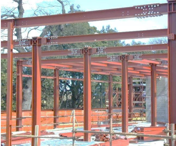
Figura 153: Vigas e pilares em aço corten.
