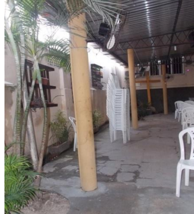
Figura 51: Pilotis do Pátio, imitando o do Bloco 01.
