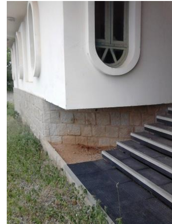
Figura 97: Imagem da sala em balanço.
