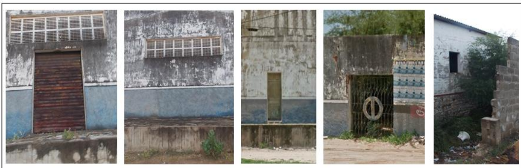
Figura 76: Esquadrias do Bloco 01.
