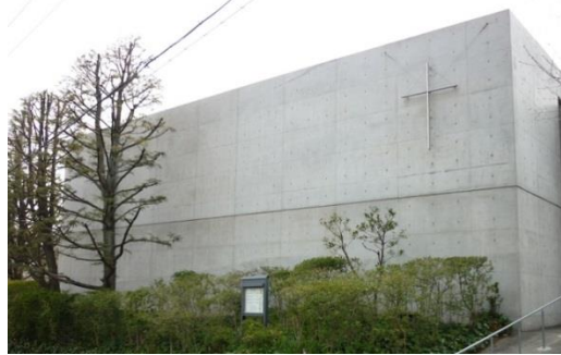
Figura 150: Concreto armado aplicado na parede.
