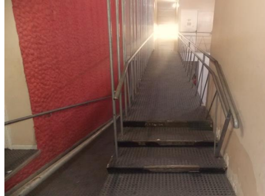
Figura 45: Degraus para acesso ao segundo lance da rampa.
