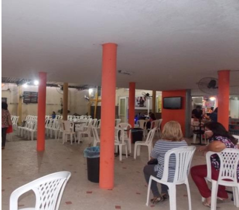
Figura 50: Pilotis do Bloco 01 .
