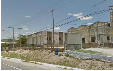
Figura 91: Vista geral do Bloco 04 e seu entorno.
