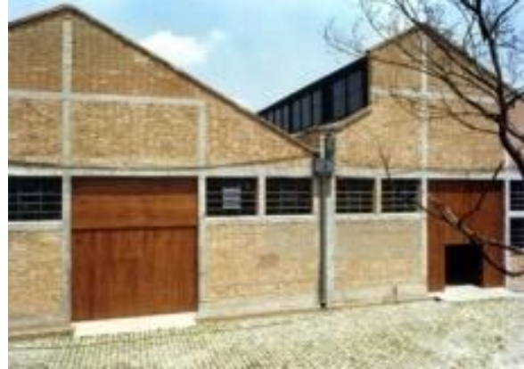
Figura 4: Paredes originais do galpão sem os rebocos, abril 1980 .
