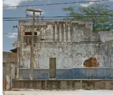
Figura 71: Fachada remanescente do galpão que ruiu e trecho protomodernista.
