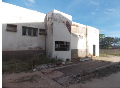
Figura 105: Vista externa com piso da balança.
