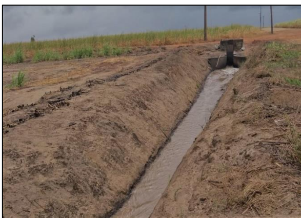
Figura 12. Baía Formosa/RN: Canal utilizado para distribuição da água em canavial (2018).
