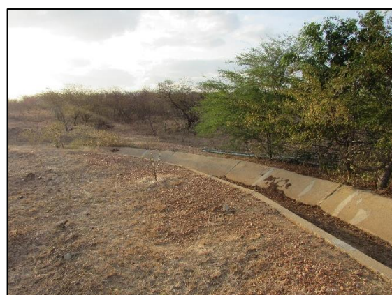
Figura 28. Perímetro irrigado de Cruzeta: estrutura original do canal principal (2018).
