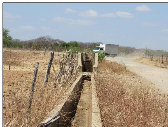
Figura 60. Perímetro Irrigado Sabugi – Caicó/RN: estrutura do canal principal (2018).
