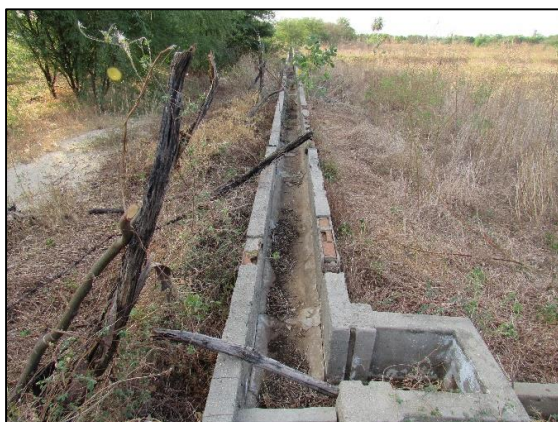
Figura 59. Perímetro Irrigado Itans – Caicó/RN: estrutura do canal secundário (2018).
