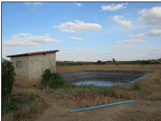
Figura 25. Perímetro irrigado de Cruzeta: sistema de armazenamento de água (2018).
