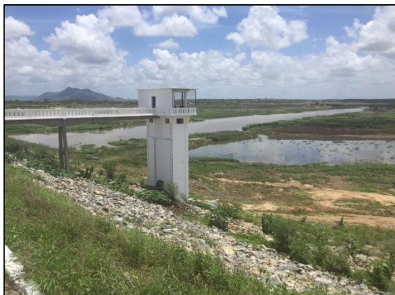
Figura 57. Caicó/RN: visão panorâmica do açude Itans (2018)
