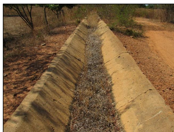
Figura 62. Perímetro Irrigado de Pau dos Ferros: trecho do canal principal (2018).
