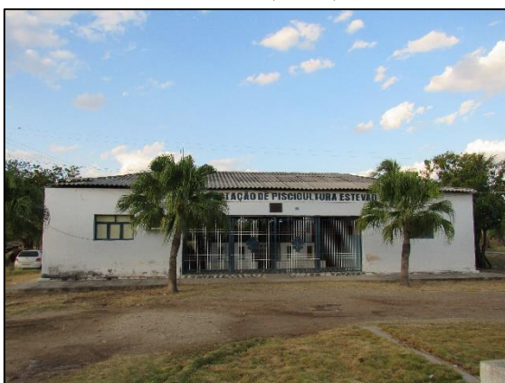
Figura 18. Caicó/RN: Visão panorâmica da sede administrativa da Estação de Piscicultura Estevão de Oliveira (2018).
