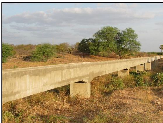
Figura 23. Perímetro irrigado de Cruzeta: visão externa dos novos canais de fornecimento de água (2018).
