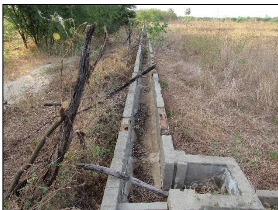
Figura 31. Perímetro irrigado de Itans - Caicó/RN: estrutura do canal secundário sem presença de água (2018).
