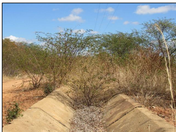
Figura 35. Perímetro irrigado de Pau dos Ferros: estrutura do canal principal ocupada pela vegetação da caatinga (2018).
