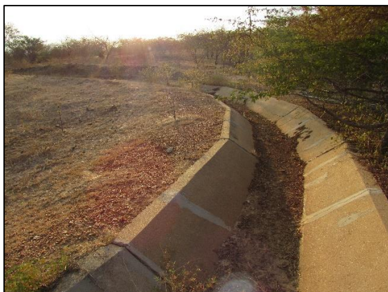
Figura 61. Perímetro Irrigado de Cruzeta: estrutura do canal secundário (2018).
