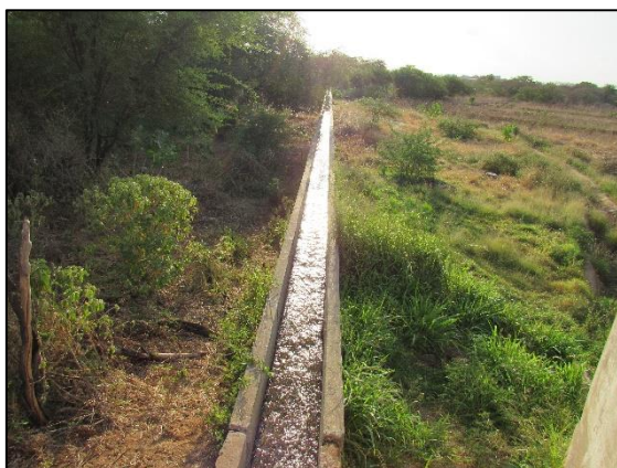
Figura 29. Perímetro irrigado de Itans – Caicó/RN: estrutura do canal principal com presença de água (2018).
