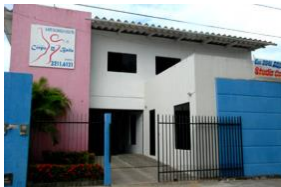
Figura 27 - Studio Corpo de Baile edifício anexo.
