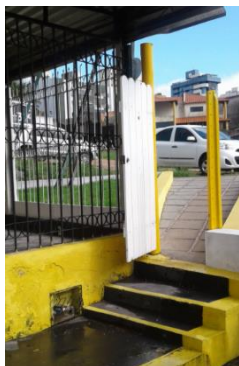
Figura 6 - Acesso ao estacionamento.
