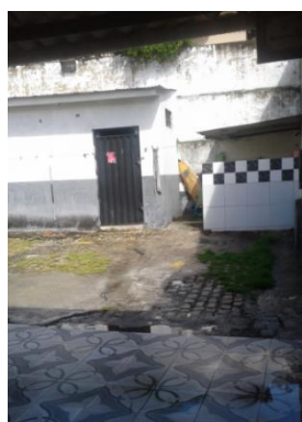
Figura 14 - Fundos da edificação, pavimento superior.
