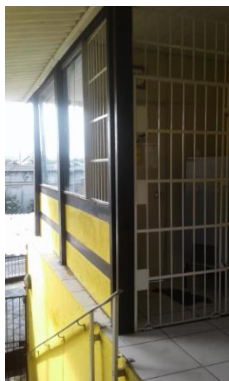
Figura 24 - Acesso a Sala 05.
