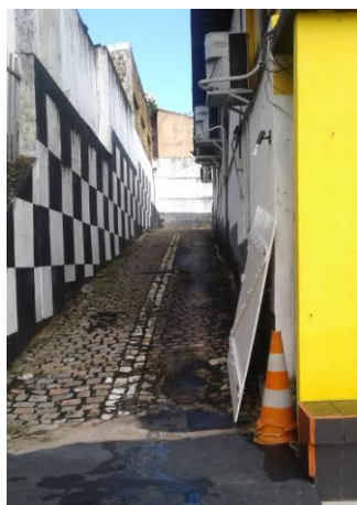
Figura 4 - Acesso lateral esquerdo para os fundos do pavimento superior.
