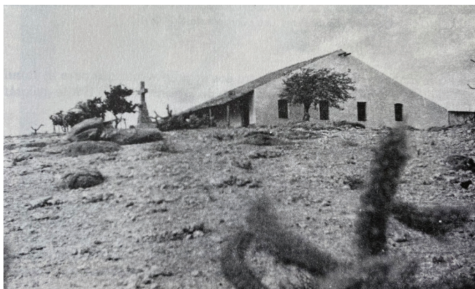
Casa-grande de duas águas. Fazenda Ingá, município de Acari, Rio Grande do Norte. Sempre “atrepada” nos altos, na defesa de todos os dias contra o calor e o cangaço (Foto do autor).
