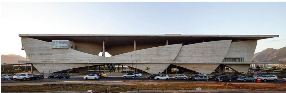
Figura 17 – Edifício da Cidade das Artes
