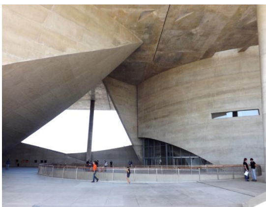
Figura 18 – Monumentais empenas curvas e pilares inclinados
