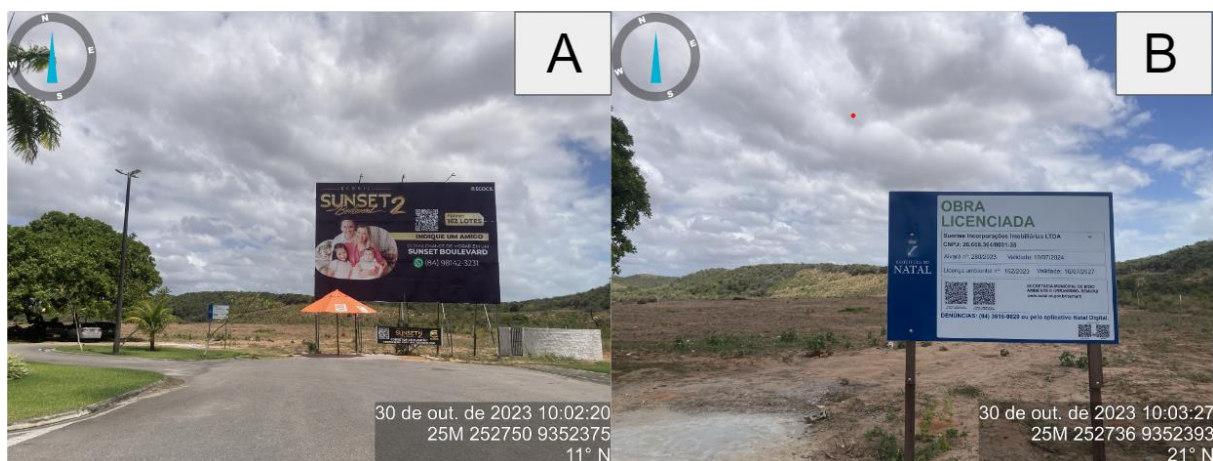
Figura 5.1 - (A) Placa e local de onde será construído o condomínio Sunset Boulevard 2 . (B) Placa disposta no local, informando o licenciamento da obra, com alvará disponível em qr code .
