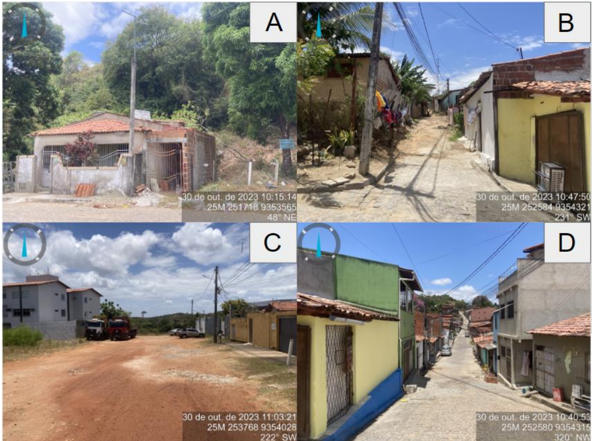
Figura 5.9 - (A) Construção de casa em local inadequado nos limites da Subzona de conservação 1-A no bairro de Pitimbú, conjunto Cidade Satélite. (B) Rua não pavimentada e com dezenas de residências inseridas dentro da Subzona de Conservação 1-A no bairro de Cidade Nova, conjunto Nova Cidade. (C) Rua não pavimentada na Subzona de uso restrito 2 no bairro de Candelária. (D) Rua pavimentada inserida na subzona de conservação 1-A no bairro de Cidade Nova, conjunto Nova Cidade.
