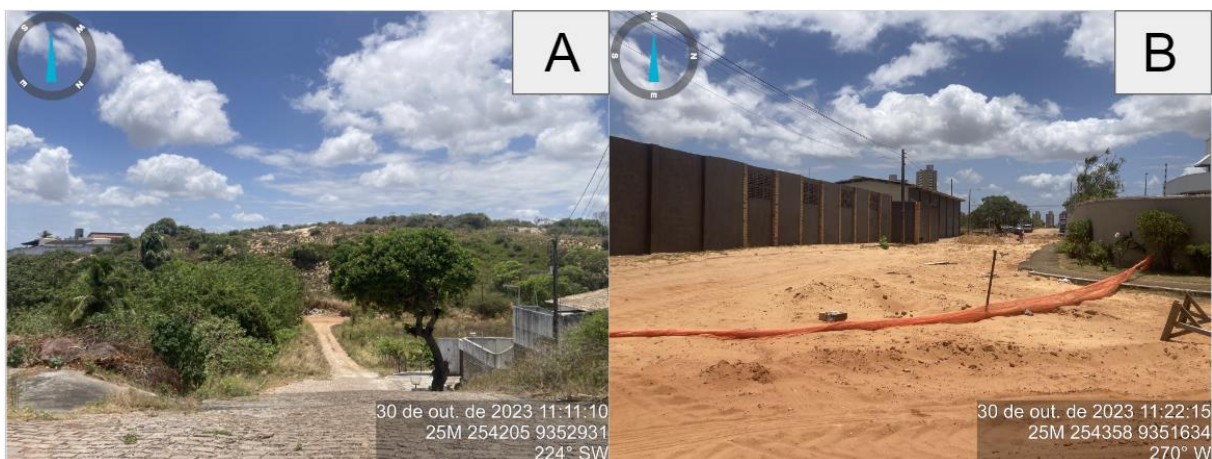
Figura 5.3 – (A) Vista do conjunto SanValle. (B) Rua não pavimentada e canteiro de obras no conjunto SanValle.
