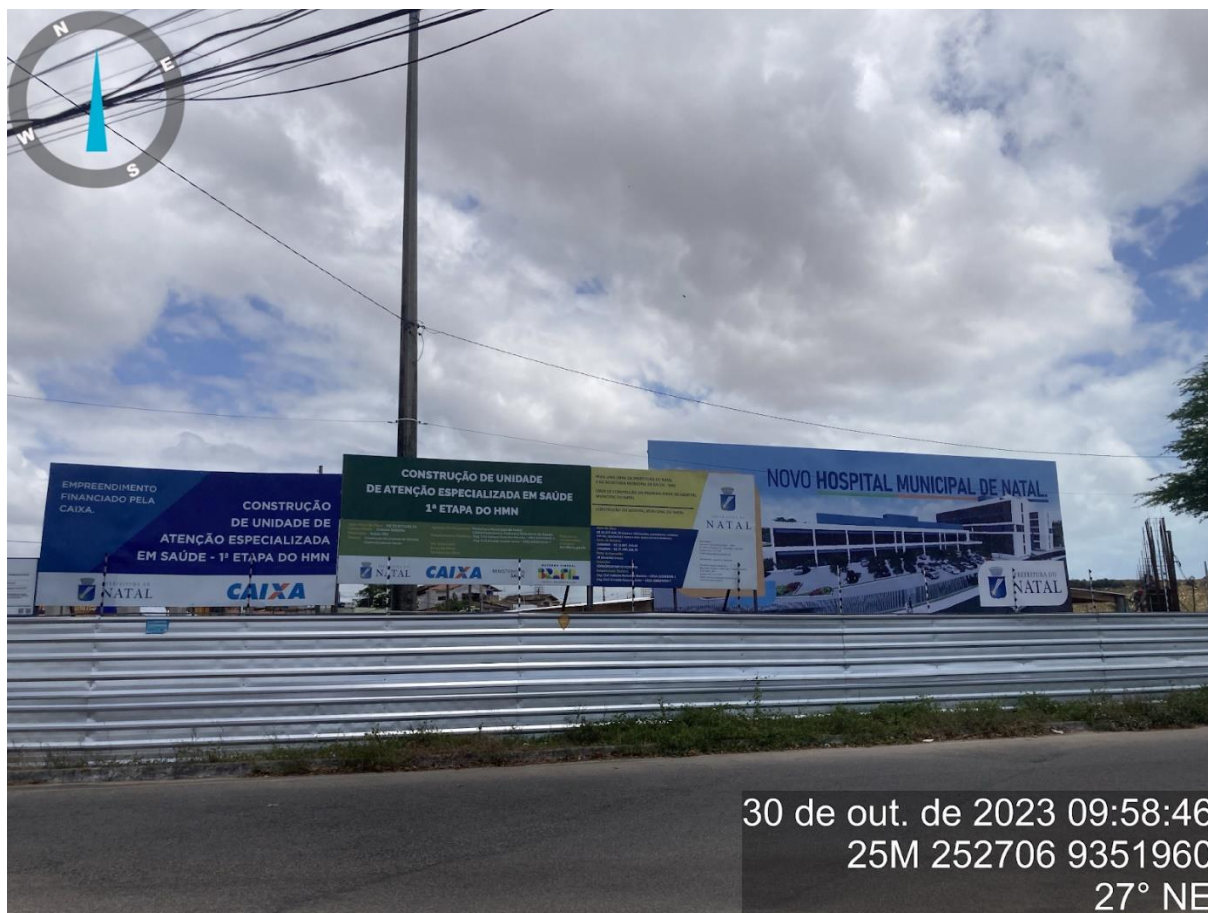
Figura 5.8 - Construção do Novo Hospital de Natal da nova Subzona 3, onde até mudança no novo plano diretor, pertencia à subzona de conservação 1A, que impossibilitava construções em seus domínios.
