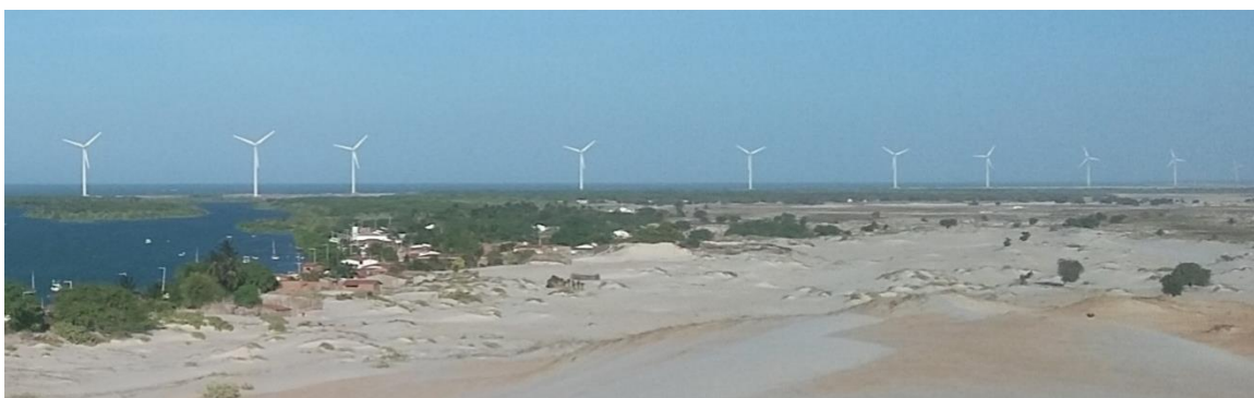
Figura 6 – Parque eólico Aratuá I. com visão para os aerogerados localizados em planície arenosa no qual segue ardeada de canais de maré, manguezal e campo de dunas.
