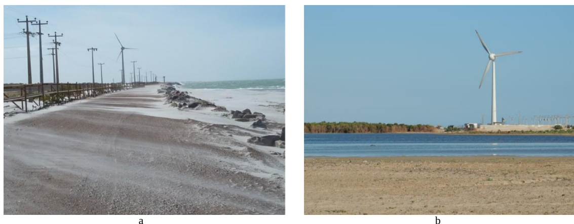
Figura 1.11- (a) Intensa movimentação de sedimentos entre a face de praia e pós-praia, onde foram locadas instalações da indústria petrolífera, devido à ação dos ventos alísios. (b) Vista sul dos aerogeradores, mostrando fragmento de mangue e planície flúvio-marinha alagada.
