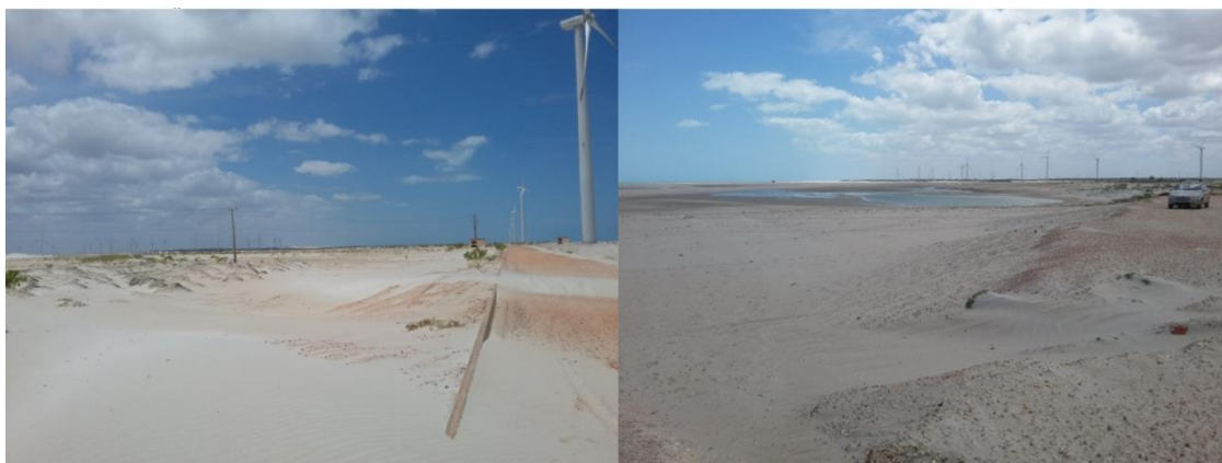
Figura 1.13 - - Parque eólico Miassaba II localizado em faixa de praia. Devido ao intenso fluxo de ventos, observa-se acentuada movimentação de sedimentos o que acaba por recobrir parte do acesso aos aerogeradores.
