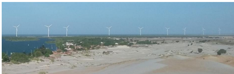
Figura 04 – Vista geral de sul (continente) para norte (Oceano Atlântico) do Parque Eólico Aratuá I com os aerogeradores localizados sobre a planície arenosa e setores de pós-praia e circundada por canais de maré, manguezais e campo de dunas móveis.
