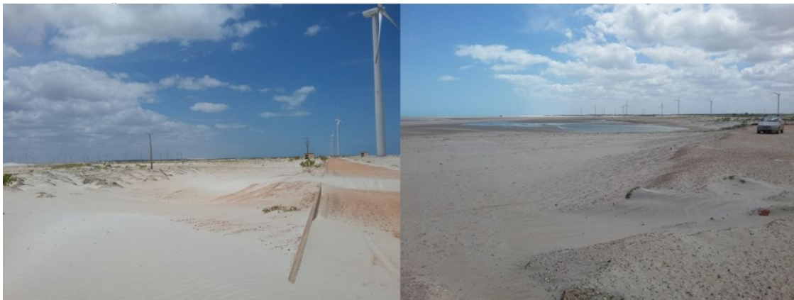
Figura 5 – Parque eólico Miassaba II localizado em faixa de praia. Devido ao intenso fluxo de ventos, observa-se acentuada movimentação de sedimentos o que acaba por recobrir parte do acesso aos aerogeradores.
