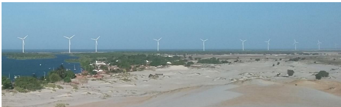
Figura 1.15 – Parque eólico Aratuá I. com visão para os aerogerados localizados em planície arenosa no qual segue ardeada de canais de maré, manguezal e campo de dunas.
