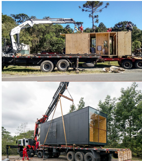
Figura 26 - Transporte das casas MINIMOD em grua.
