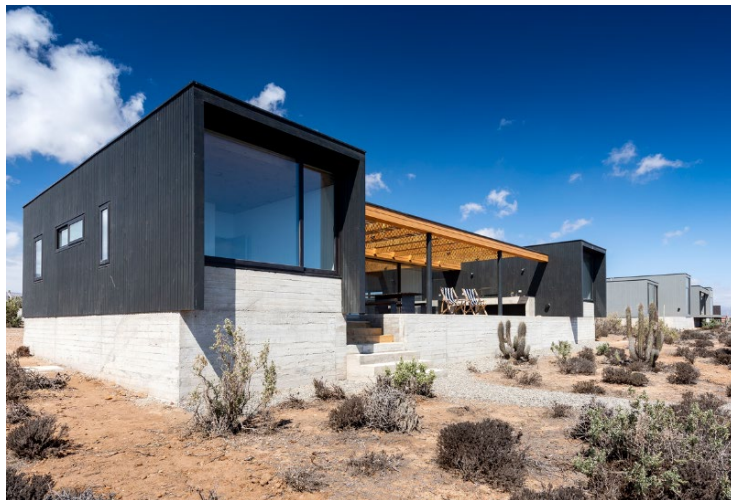
Figura 30 - Modelo construído de uma Casa Aditiva.
