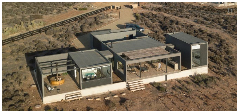
Figura 27 - Modelo construído de uma Casa Aditiva.
