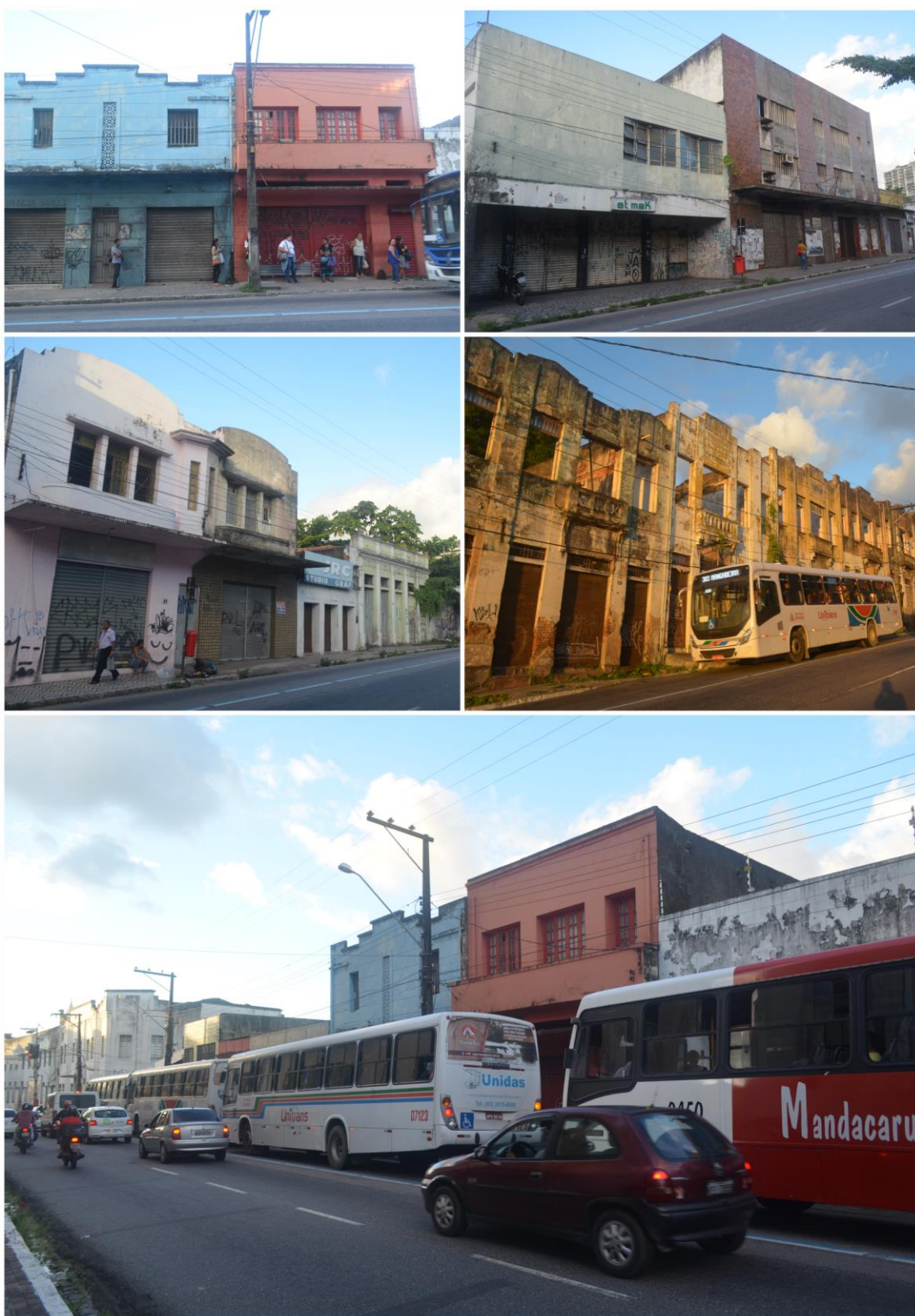
Figura 85 – Percurso inicial do trajeto das linhas de ônibus, partindo da Via São Miguel até o fim da Rua João Suassuna. Nas quatro primeiras imagens, percebem-se alguns dos imóveis que se encontram abandonados no percurso. A última imagem ilustra a presença massiva das linhas de ônibus na paisagem urbana do trajeto. Fonte: Acervo Pessoal.
