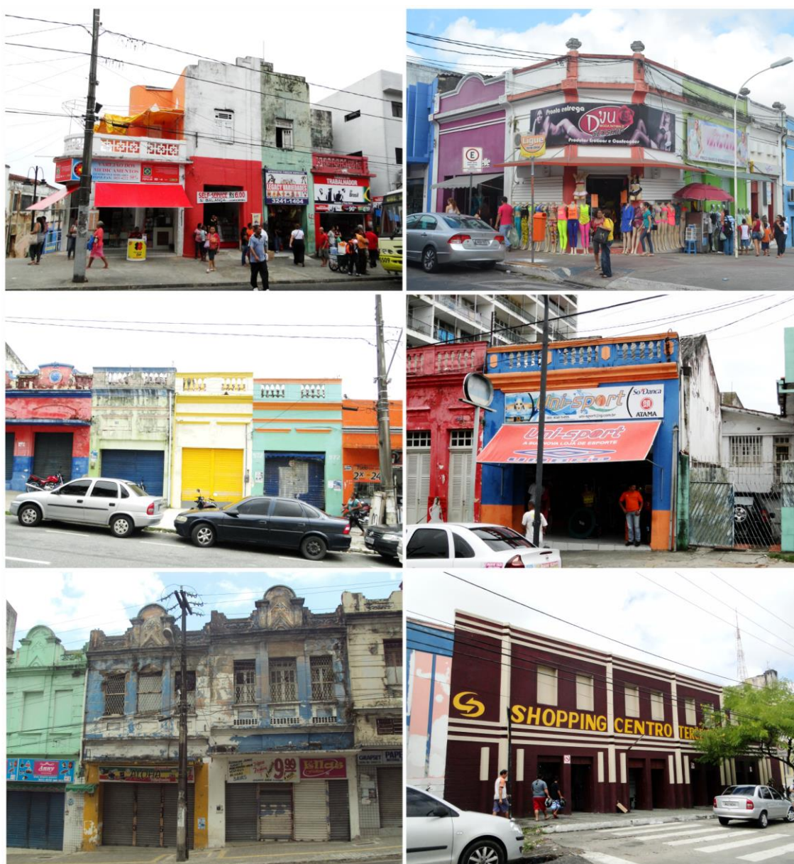
Figura 103 – Exemplos de descaracterização para comércio varejista nos eixos mais integrados da Cidade Alta. A última imagem é a de um dos shoppings populares (Shopping Centro Terceirão) construídos para antigos vendedores ambulantes. Fonte: Acervo pessoal.
