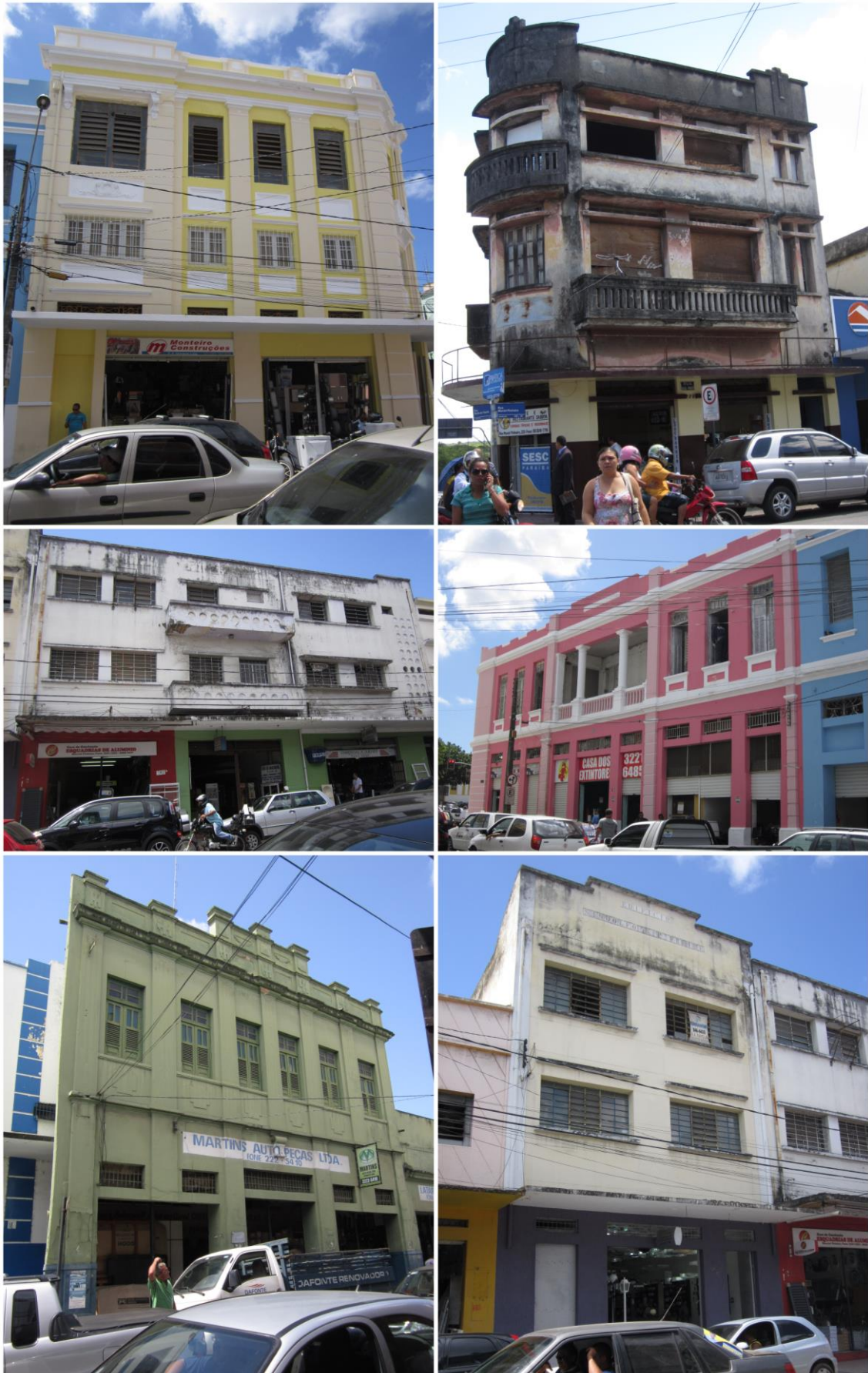
Figura 81 – Pavimentos superiores subutilizados na Rua Maciel Pinheiro. Fonte: Acervo pessoal.
