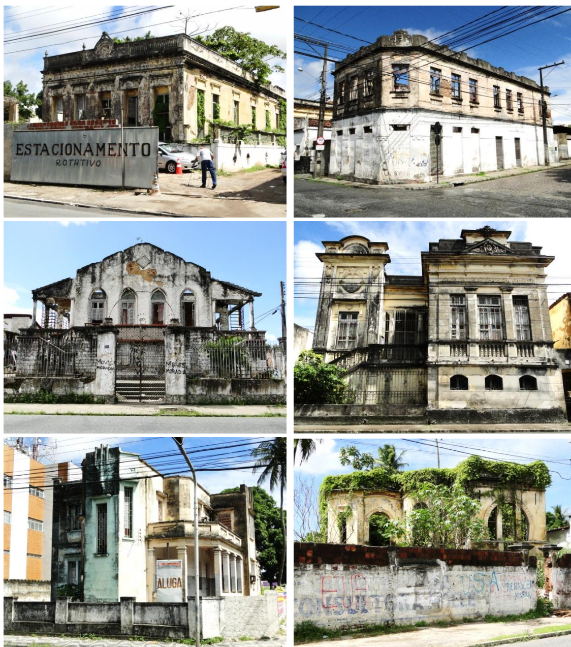
Figura 105 – Casarões abandonados nas Avenidas Trincheiras e João da Mata. Fonte: Acervo Pessoal.
