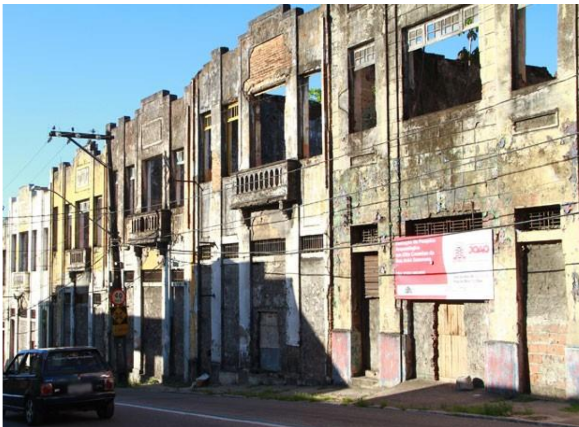
Figura 76 – Conjunto em ruínas na Rua João Suassuna. Fonte: Portal G1.
