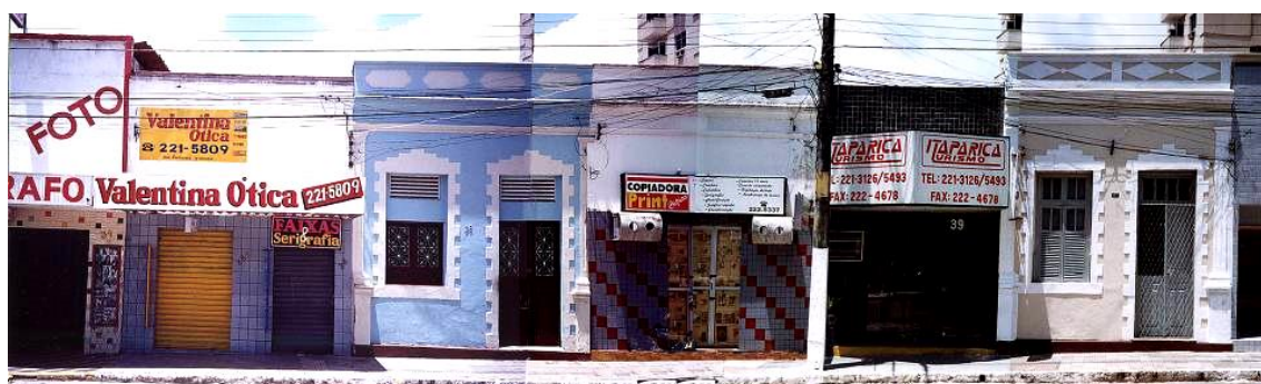
Figura 102 – Imóveis descaracterizados na Cidade Alta, Natal-RN. Fonte: MusA.
