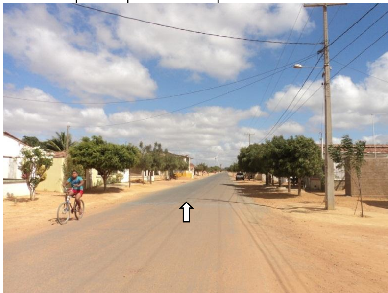
Figura 28 – Asfalto colocado no assentamento Santa Clara pela empresa Gestamp Eólica Brasil 80 .
