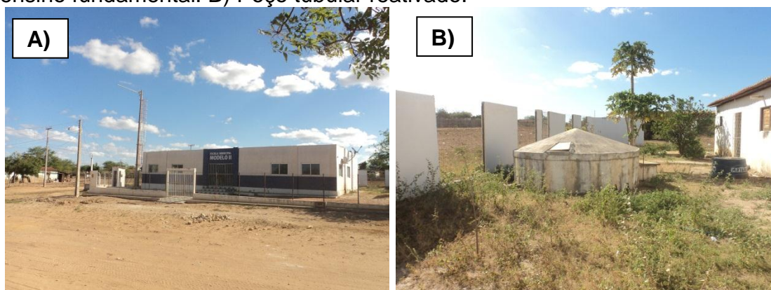
Figura 20 – Estruturas reformadas pela empresa Gestamp Eólica Brasil. A) Escola de ensino fundamental. B) Poço tubular reativado.
