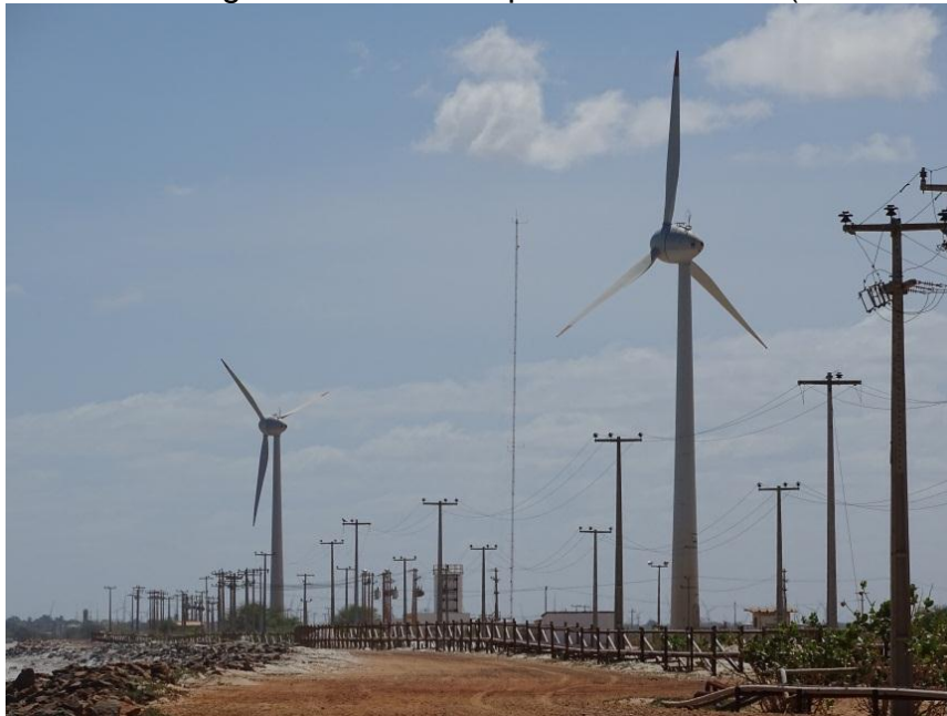
Figura 12 – Aerogeradores do Parque Eólico Macau (Macau-RN) 44 .
