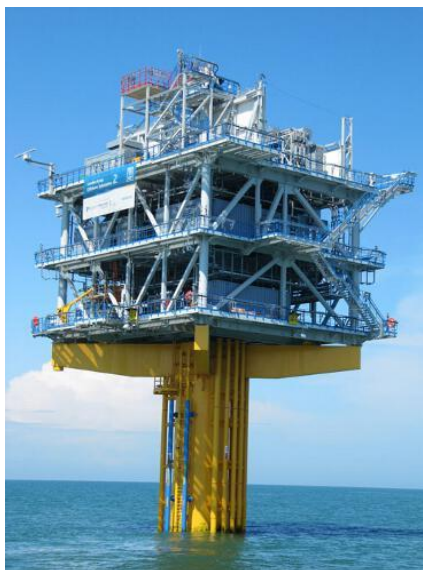
Figura 4.13 - Subestação offshore London Array Phase I - Substation 2 Fonte: 4C Offshore
