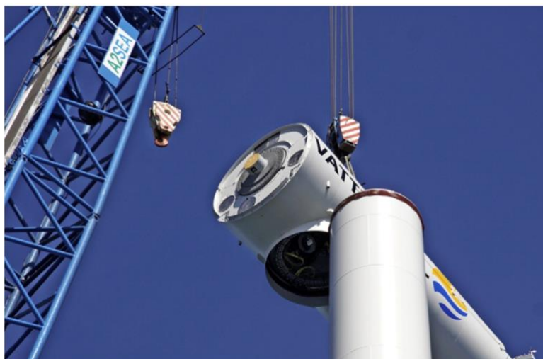
Figura 4.10 - Operação de instalação de nacela sobre torre de aerogerador Fonte: THOMSEN (2012)
