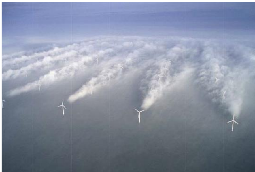
Figura 2.10 - Efeito esteira em uma UEO
