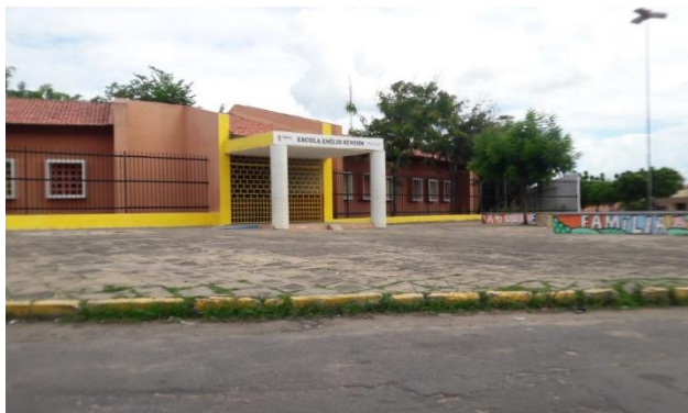
Figura 4 – Fachada da Escola Emílio Sendim
