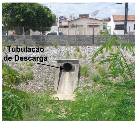
Figura 4.1 Tubulação de descarga na Lagoa, antes da instalação da plataforma
