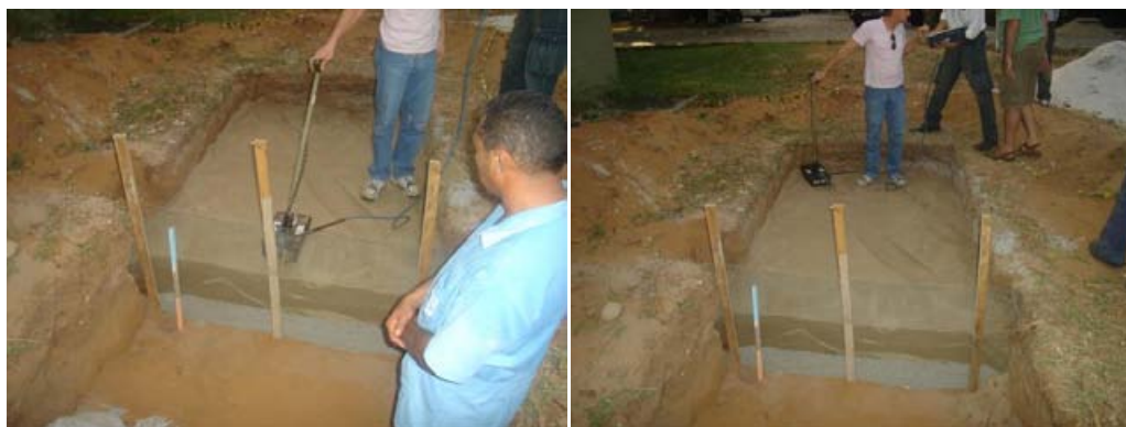
Figura 8.2 - Vista geral do local do experimento no CCET, onde podem ser evidenciadas as camadas de brita (basal) e areia grossa, com escala (20cm na porção inferior esquerda da trincheira) e os locais de aquisição (longitudinal e diagonal) GPR.
