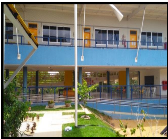
Ilustração 07 – Salas de aula e área coberta da escola
