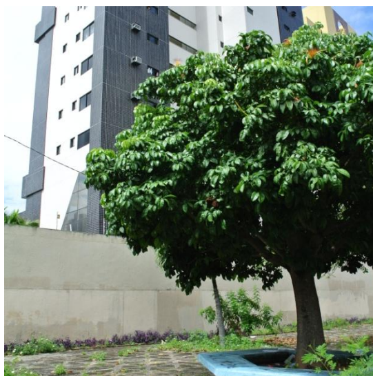
Figura 30 – Fachada cega voltada para o Parque Ney Aranha Marinho
