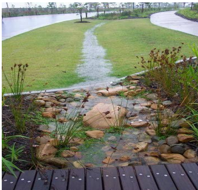
Figura 62 – Sistema de retenção e infiltração
