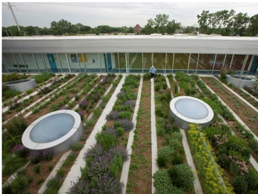
Figura 58 - Telhado do Gary Comer Youth Center com horta comunitária
