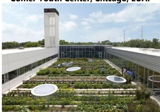
Figura 9 - Horta no telhado do Gary Comer Youth Center, Chicago, EUA.
