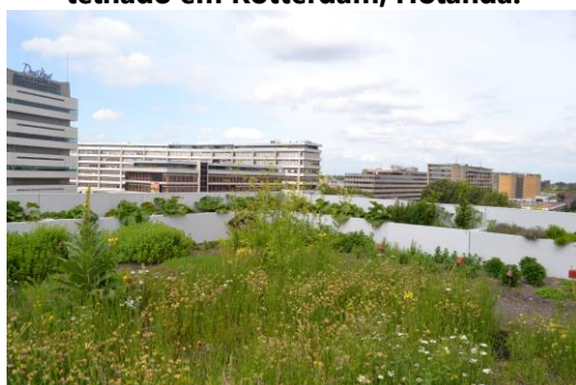
Figura 27 – Horta com plantio direto no telhado em Rotterdam, Holanda.
