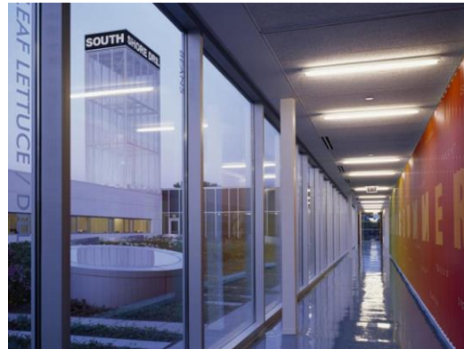
Figura 59 - Telhado do Gary Comer Youth Center visto de dentro do edifício
