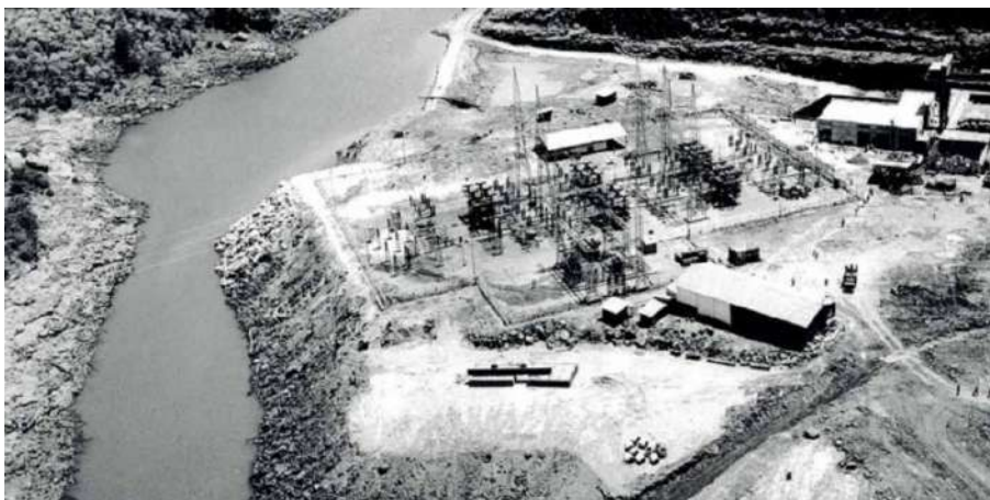
Figura 2.3 – Construção da Usina Hidrelétrica de Paulo Afonso/BA.
