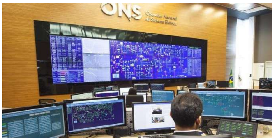
Figura 2.5 – Centro de Operações Integradas da ONS no Rio de Janeiro.
