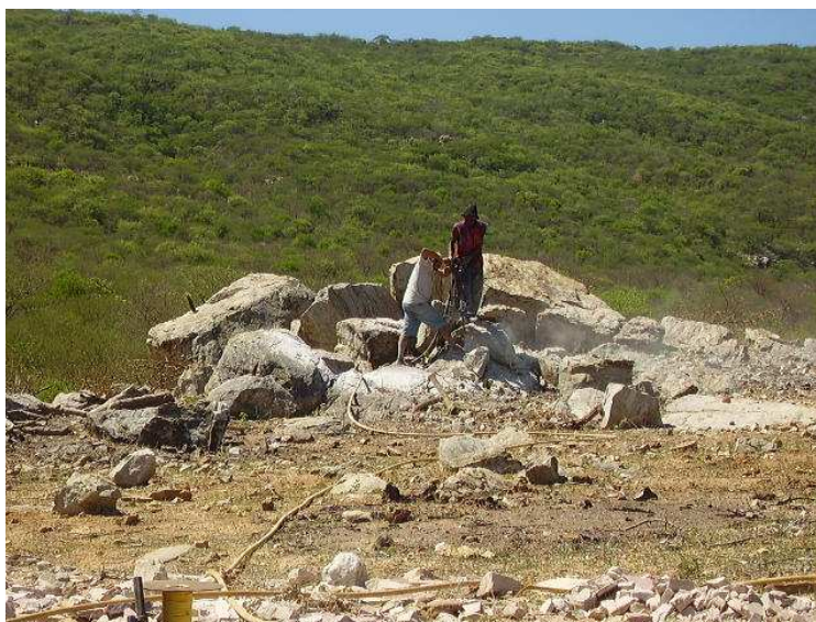
Figura 11. Trabalho do compressorista perfurando as rochas na atividade de desmonte. Parelhas/RN. Foto: Elisângela Lima, Fevereiro/2008.
