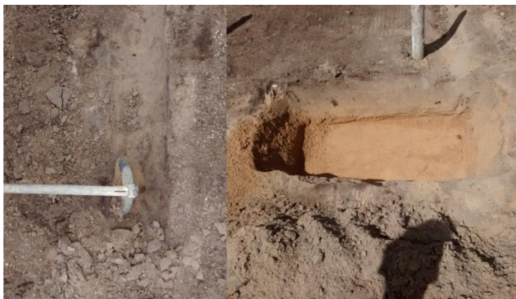
Figura 5. Construção de canaletas e valas para escoamento do chorume.
