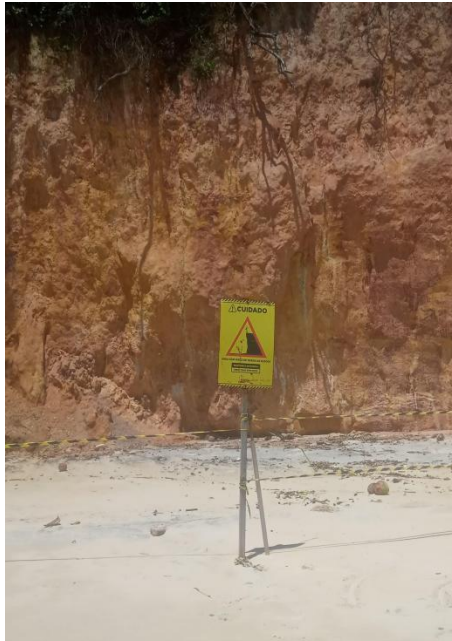
Figura 7 – Placas de deslizamento (Praia do Curral)
