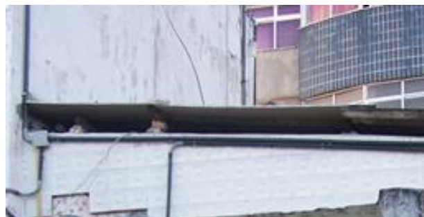
Figura 30: Vista da telha de fibrocimento.
