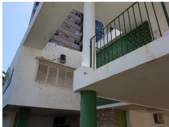
Figura 45: Abertura na face superior da varanda.
