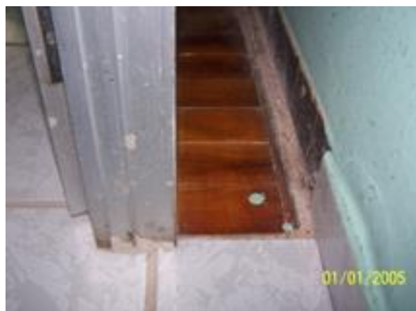
Figura 33: Piso de taco encontrado por baixo da cerâmica.
