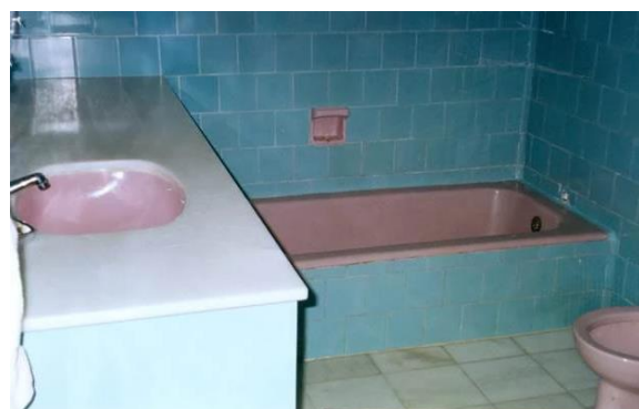
Figura 48: Banheiro da suíte.
