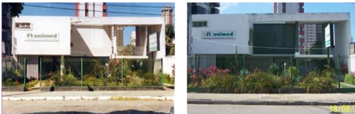
Figura 4: Comparação entre o estado da fachada em 2003 e 2007
