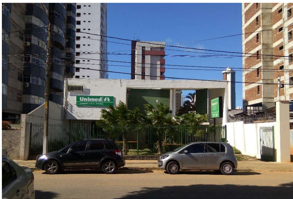
Figura 2: Vista da edificação escolhida para modelagem, em 2017.
