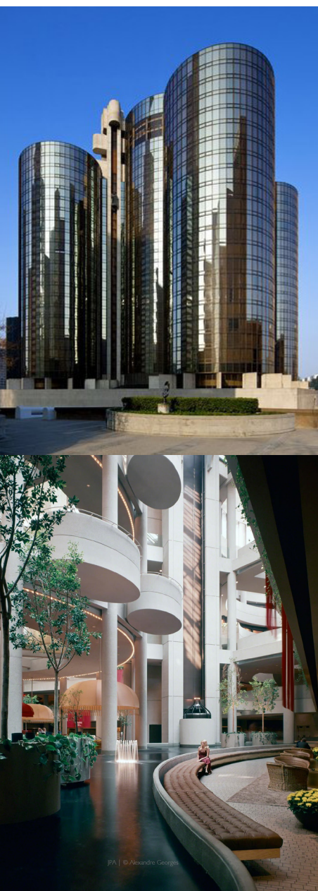
Figura 38: Exterior e interior do Hotel Bonaventure, em Los Angeles, EUA
