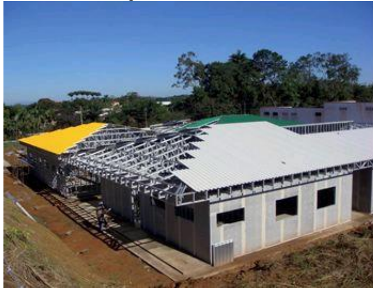
Figura 37: Cobertura em LSF
