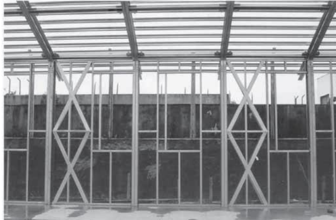
Figura 34: Contraventamento em “x” painéis LSF
