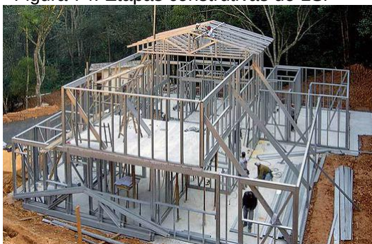
Figura 74: Etapas construtivas do LSF
