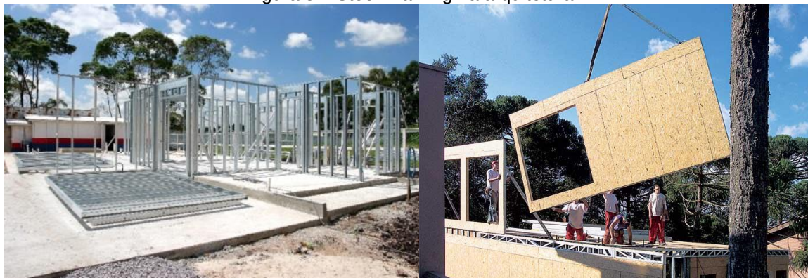
Figura 31: Steel Framing na arquitetura
