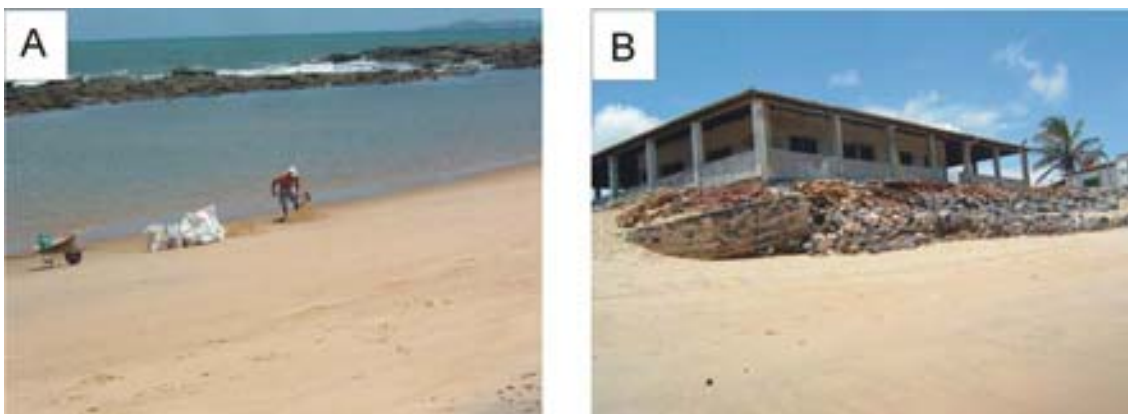
Figura 4.5 - A: Retirada de areia da zona de estirâncio para fins de construção civil. B: Construção irregular à beira-mar com muro de concreto e enrocamento de pedras soltas.
