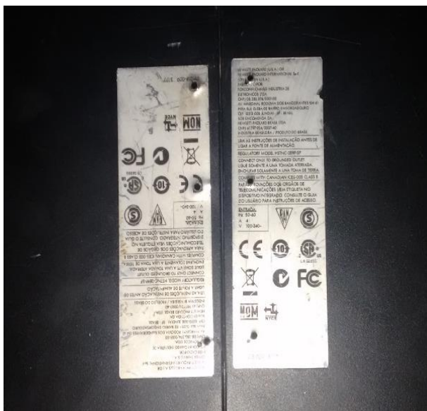
Figura 30 – Furação dos gabinetes.
