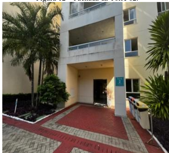
Figura 12 – Fachada da Torre 02.
