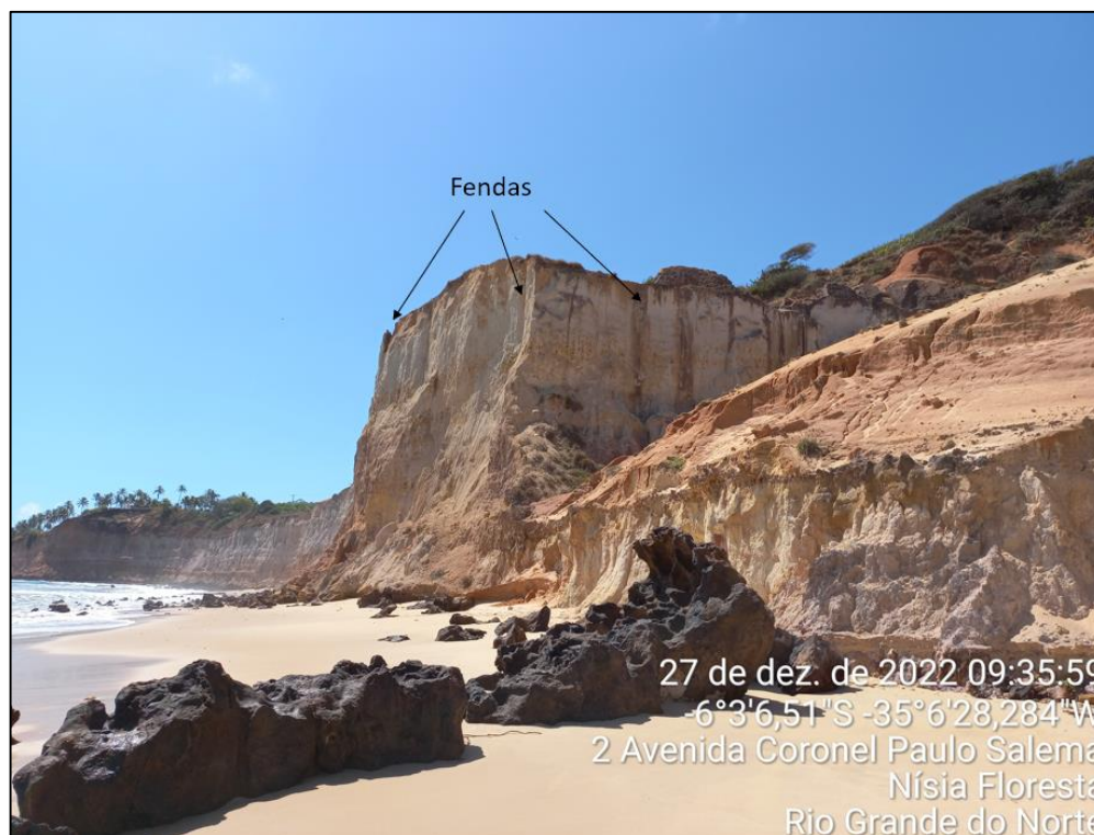
Figura 6.8 – Falésias da Praia de Barra de Tabatinga. Nota-se a presença de varias fendas nas rochas da Formação Barreiras. Atenta-se também uma menor quantidade de material na plataforma de abrasão marinha do que na Praia de Cotovelo.
