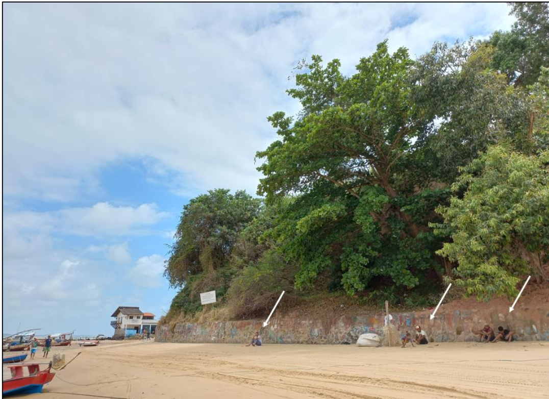
Figura 6.21 – Moradores locais sentados na base da encosta que se encontra instável, indicada plena inclinação das árvores.
