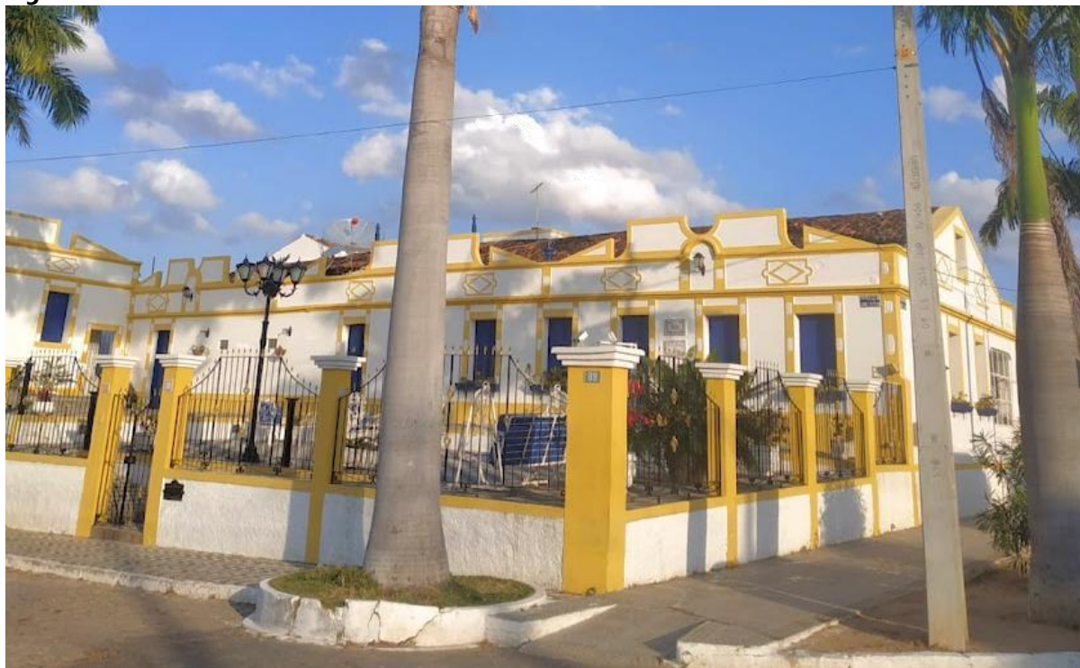
Figura 36. Casa Grande dos Pereiras
