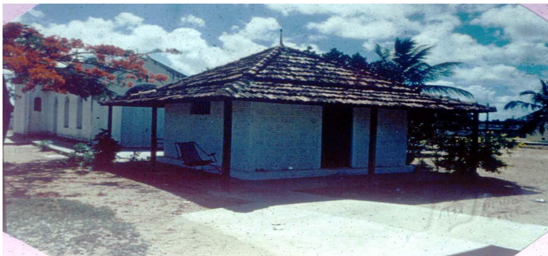
Figura 12 – Vista externa da biblioteca local
