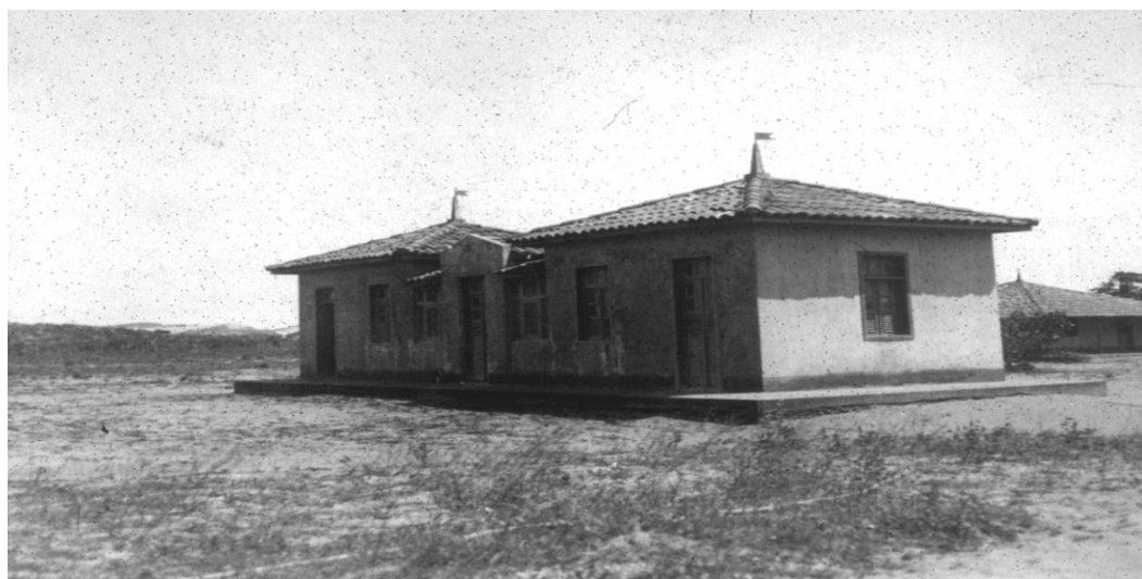
Figura 10 – Vista da cadeia masculina. Ao fundo, a casa dos soldados
