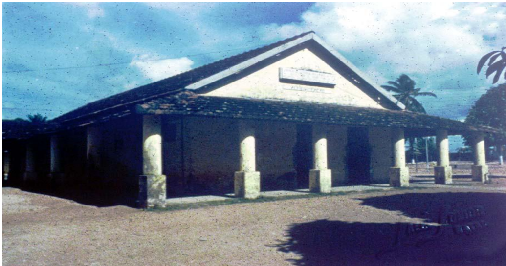
Figura 5 – Vista da enfermaria
