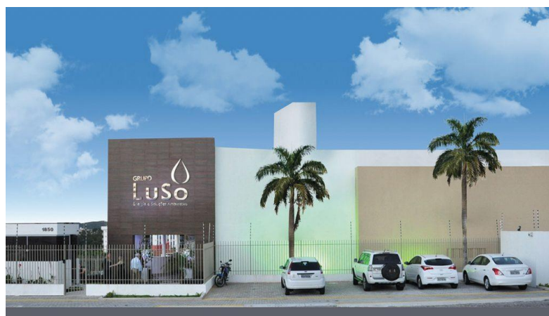
Figura 9 – Fachada da sede administrativa da CRIL Ambiental em Natal/RN
