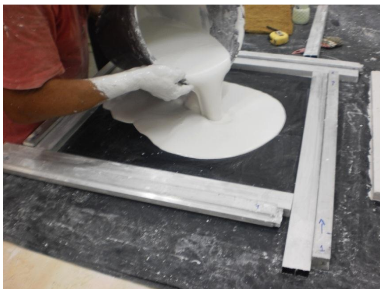
Figura 38 - Colocação da 1ª camada de gesso
