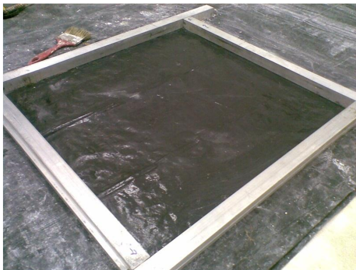
Figura 37 - Montagem de molde para confecção placas
