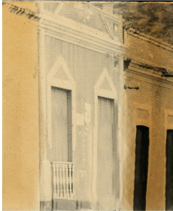
Predio onde funcionou a Loja Maçonica Fraternidade de Aracati, na rua Conselheiro Liberato Barroso nº 132, atual Rua Cel Alexanzito Costa Lima nº669. foto de 1960
