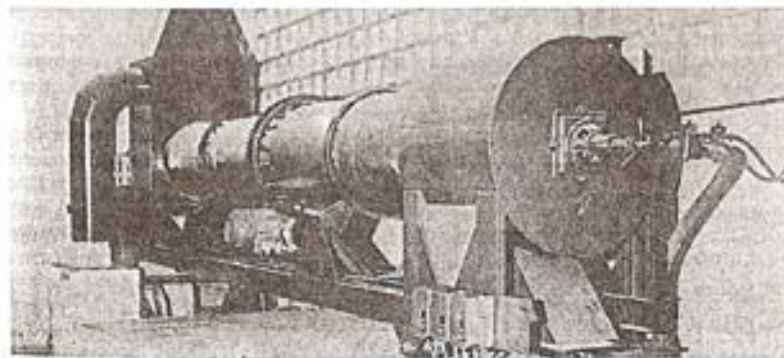
Figura 2.9 – Forno rotativo para produção de argila expandida (SOUZA SANTOS, 1992)
