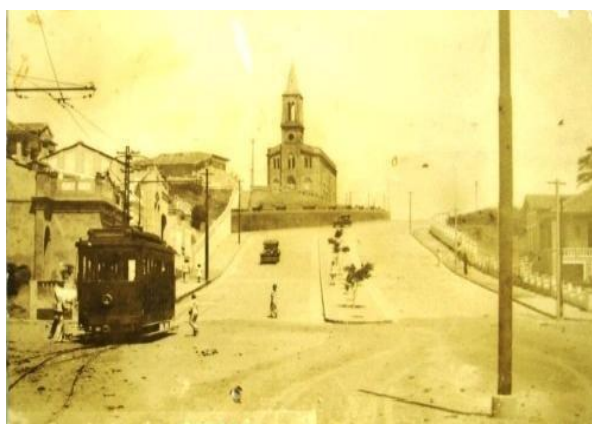
Figura 7 – Vista da Colina do Bairro Santo Antônio Fonte: Acervo Rosa Farias
