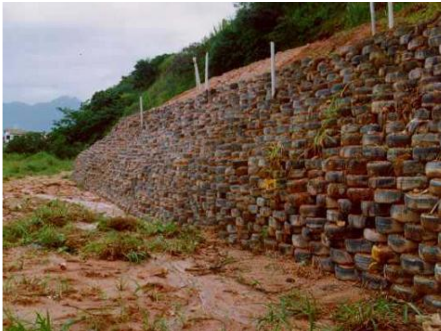
Figura 2.3 – Muro experimental solo-pneus com 60 m de comprimento e 4 m de altura (Sieira et al., 2000).
