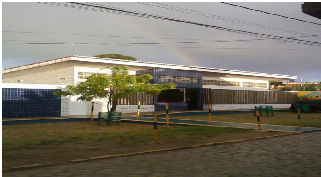
FIGURA 5: Sede atual da ADIC-RN no Bairro Passo da Pátria
