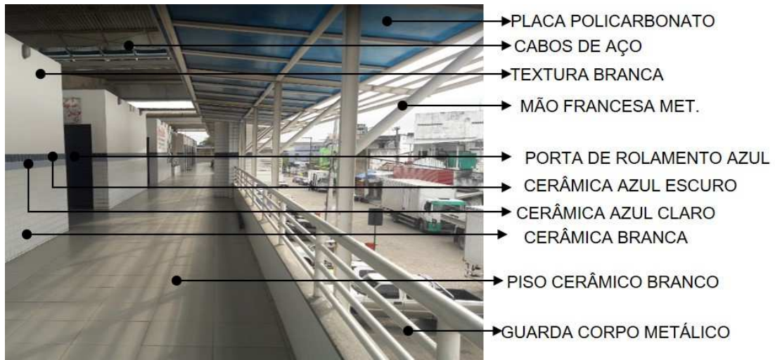
Figura 26- Materiais utilizados no Mercado Público de Cabedelo- PB.
