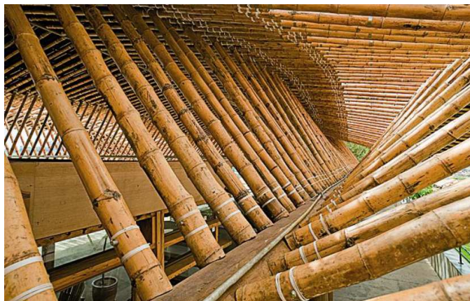
Fotografia 7- Detalhes da cobertura do Centro Cultural Max Feffer.
