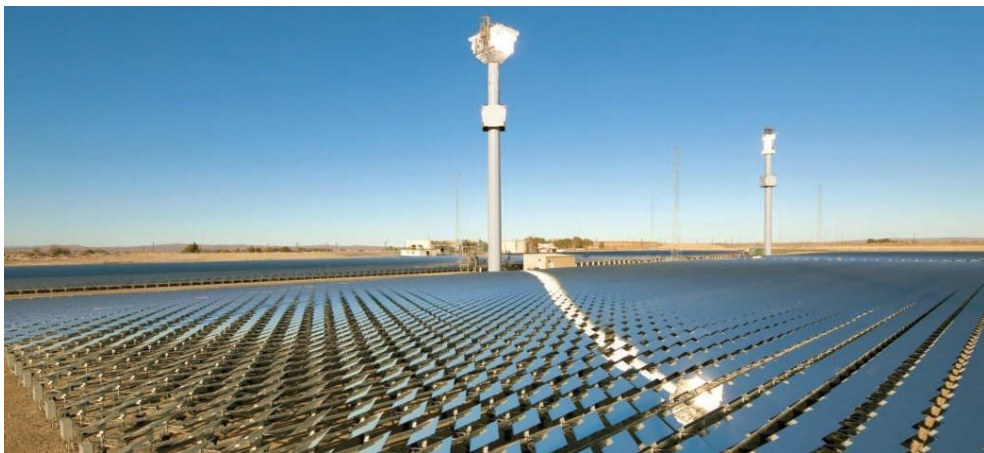
Figura 7 – Usina “ Sierra Sun Tower ” com heliostatos de pequena dimensão.
