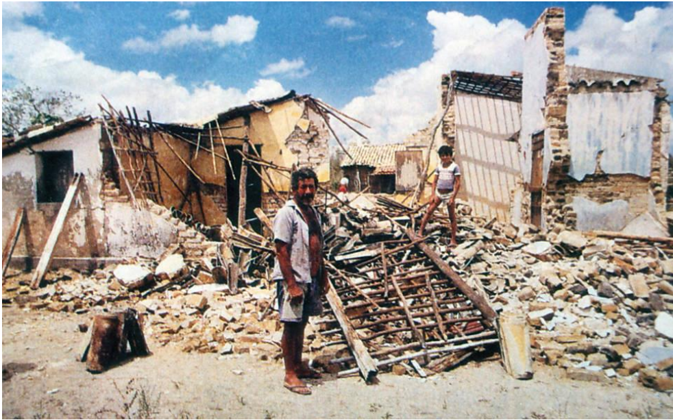
Figura 5: Residência completamente destruída pelo sismo. (Fonte: Arquivo Pessoal – Veloso).
