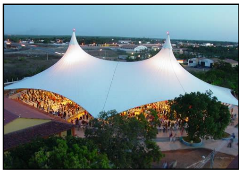
Figura 33: Exemplo de estrutura tensionada - Igreja Batista Central, Fortaleza.
