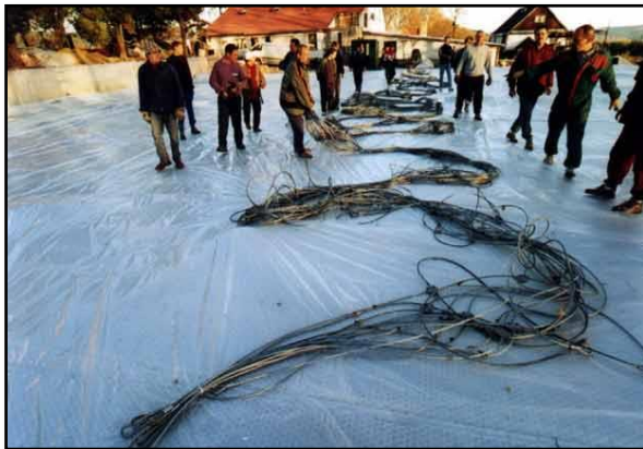
Figura 30: Cabos da estrutura inflável.
