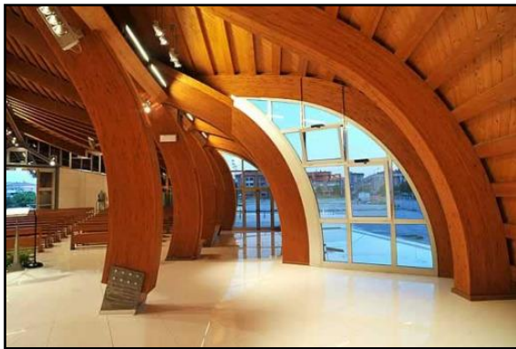
Figura 56: Aplicação da madeira laminada colada – Haras Polana.
