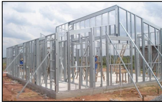
Figura 58: Construção em Steel Frame .
