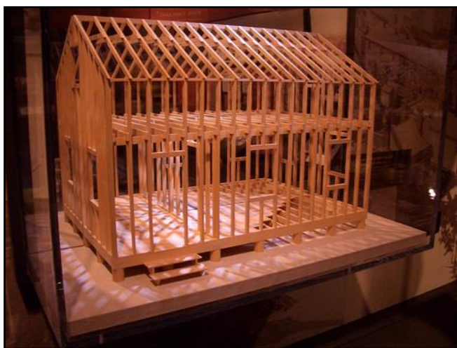
Figura 50: Técnica construtiva Balloon Framing .
