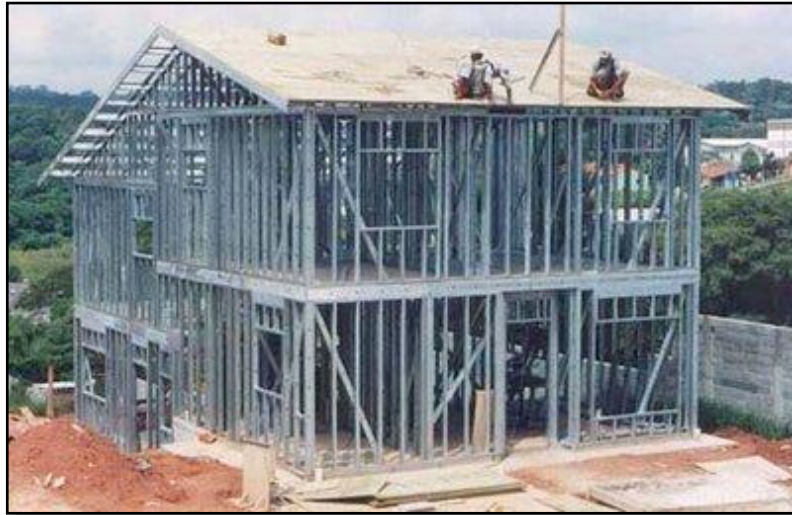
Figura 62: Construção em steel frame.
