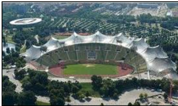
Figura 15: Tensoestruturas de Frei Otto.
