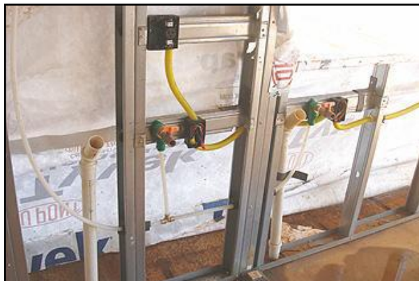
Figura 64: Steel frame com instalações elétricas e hidráulicas.
