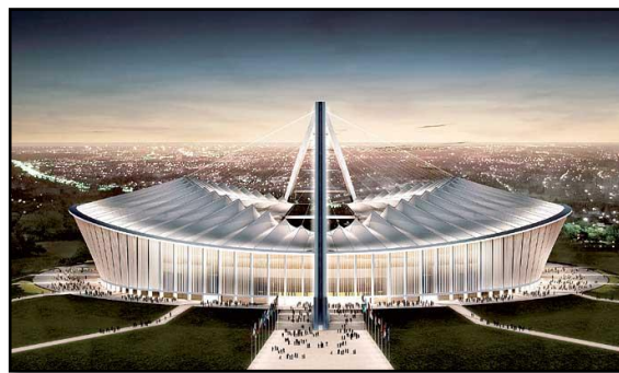
Figura 34: Exemplo de estrutura tensionada - Estádio Moses Mabhida.
