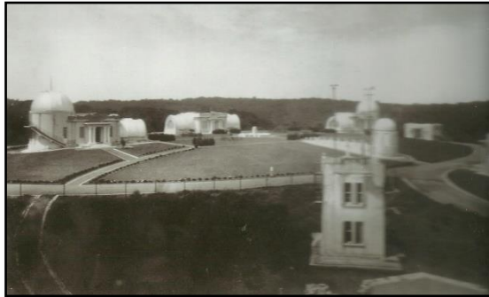
Figura 97: Conjunto das edificações.
