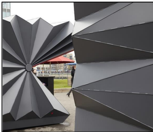
Figura 129: Vincos e Dobradiças da estrutura.
