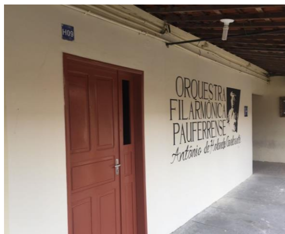
FIGURA 21: Entrada da sala depois FONTE: Acervo do autor, junho de 2017
