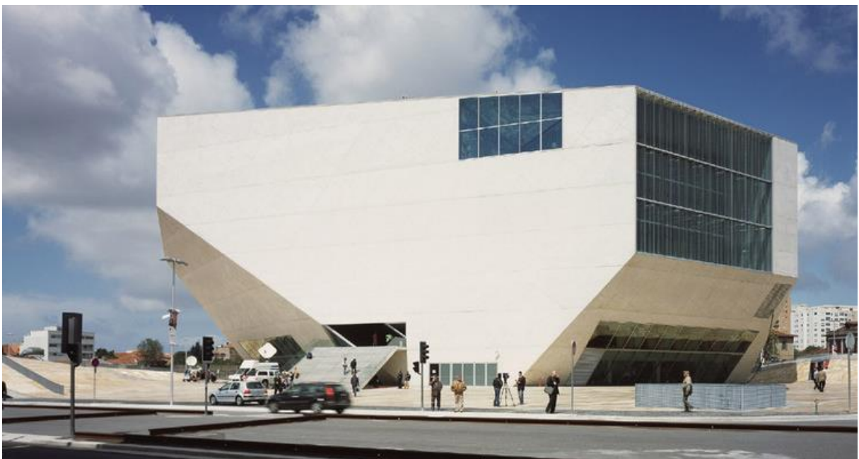
FIGURA 13: Casa da Música do Porto, Portugal Fonte: Delaqua, 2014
