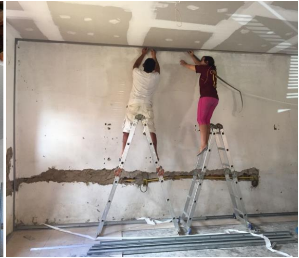
FIGURA 34: Colocação da banda acústica Fonte: Acervo do autor, maio de 2017
