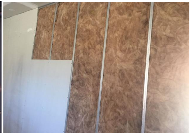
FIGURA 39: Isolamento em lâ de vidro na parede P4 Fonte: Acervo do autor, maio de 2017
