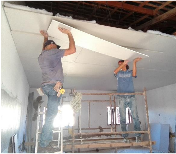
FIGURA 33: Segunda camada de gesso Fonte: Acervo do autor, maio de 2017
