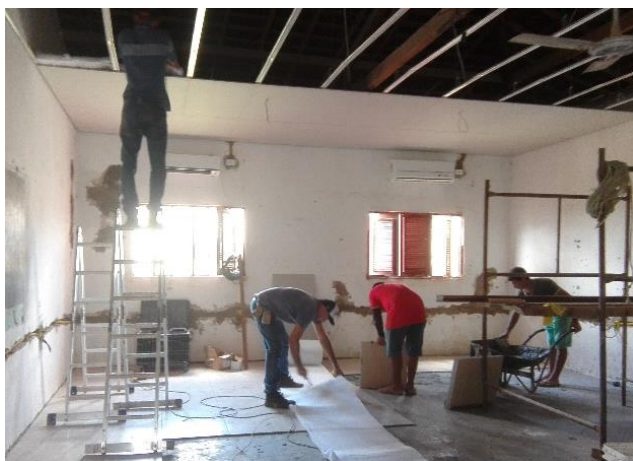
FIGURA 31: Execução do forro e do piso Fonte: Acervo do autor, maio de 2017
