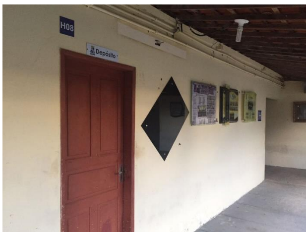
FIGURA 20: Entrada da sala antes FONTE: Acervo do autor, fevereiro de 2017
