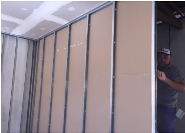
FIGURA 38: Instalação das placas de gesso na parede P4 Fonte: Acervo do autor, maio de 2017
